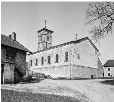
Extérieur : face latérale droite et chevet. Phot. Yves Sancey IVR43_19833900074X
