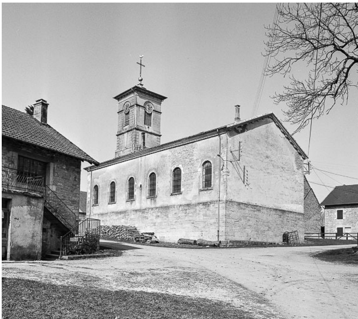
Extérieur : face latérale droite et chevet.
