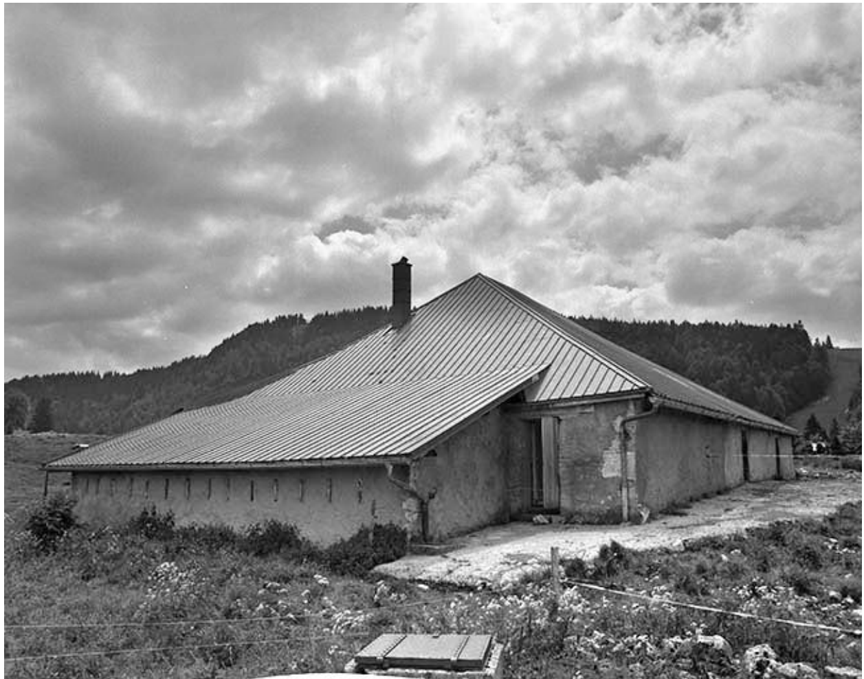
Façade postérieure vue de trois quarts gauche.
