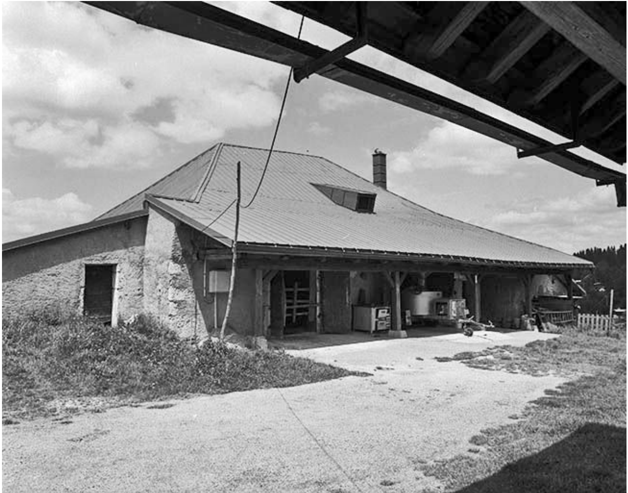
Avant-toit débordant sur la façade antérieure.
