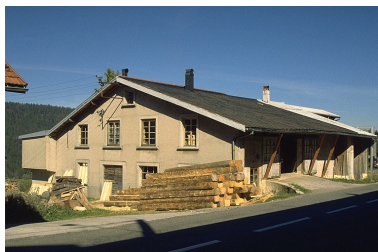
Scierie vue de trois quarts gauche. Phot. Laurent Poupard IVR43_19903900664ZA
