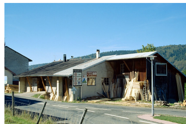
Scierie vue de trois quarts droite. Phot. Laurent Poupard IVR43_19903900663ZA
