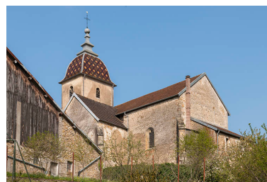
Vue depuis le sud-est.
