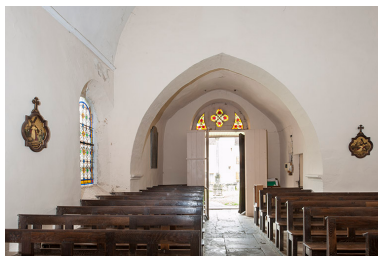
La nef depuis le sanctuaire. Phot. Jérôme Mongreville IVR43_20177001194NUC4A
