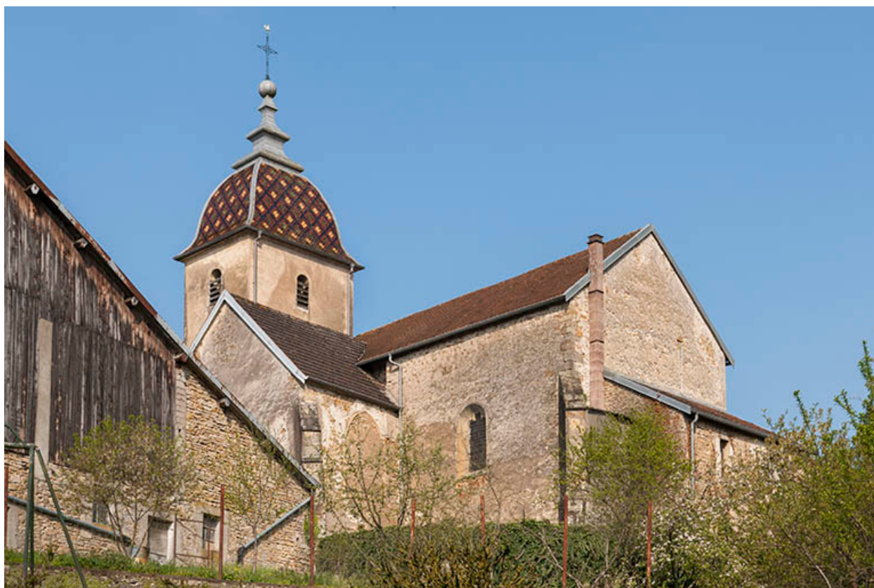
Vue depuis le sud-est.
