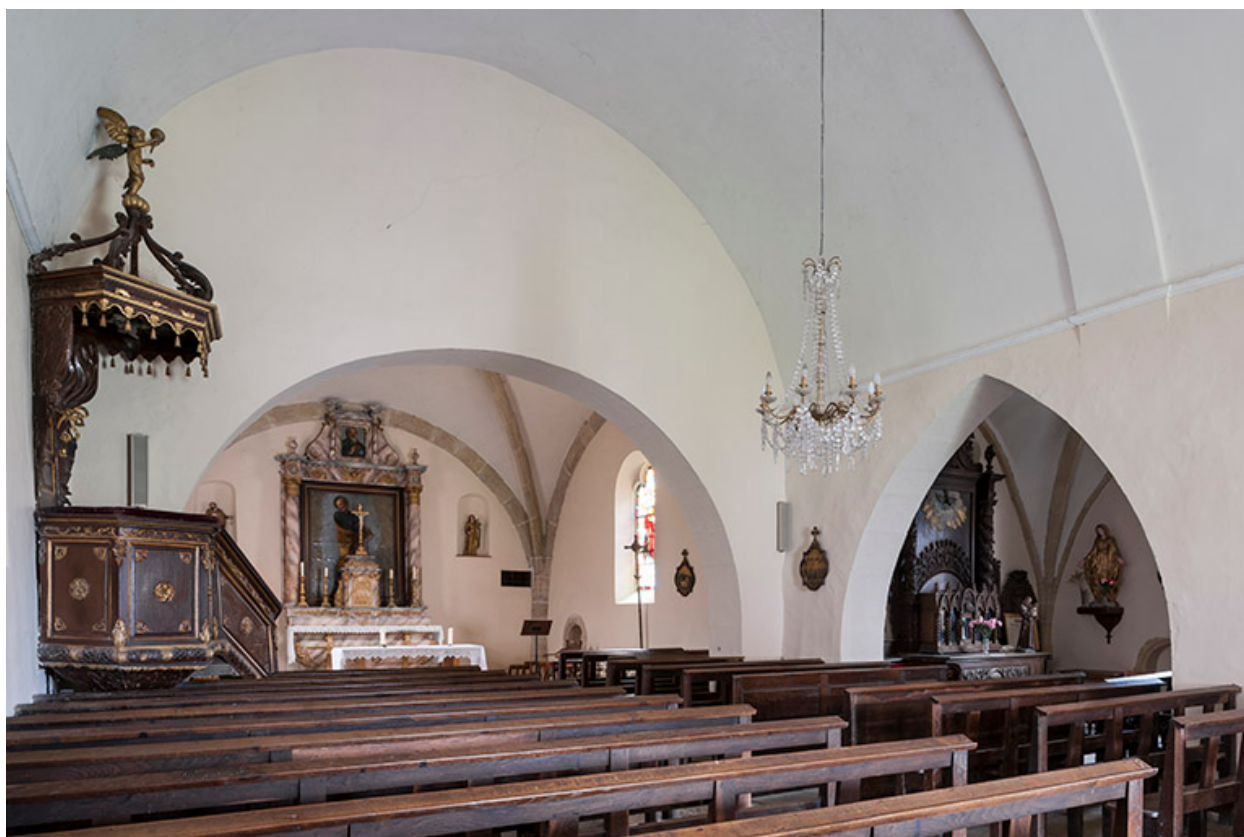
Vue générale de l'intérieur de l'édifice.
