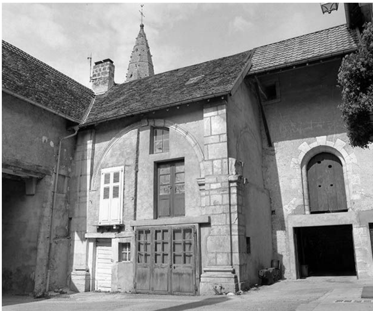
Elévation à gauche de l'entrée.
