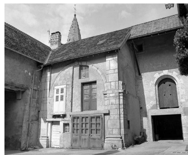
Elévation à gauche de l'entrée. Phot. Yves Sancey IVR43_19802501114X
