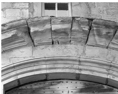
Linteau du portail. Phot. Yves Sancey IVR43_19812500291X
