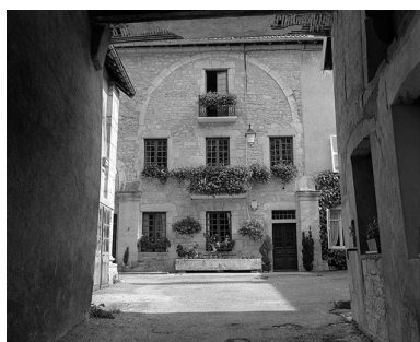
Elévation face à l'entrée. Phot. Yves Sancey IVR43_19802501115X
