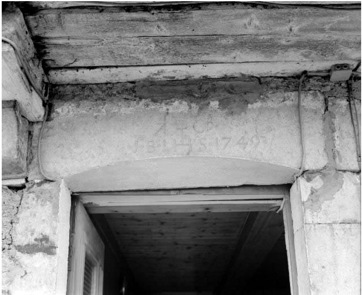
Ferme 2 : linteau de la porte d'entrée.
