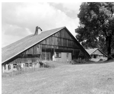
Fermes 1 et 2 : façades postérieures. Phot. Yves Sancey IVR43_19772500406X
