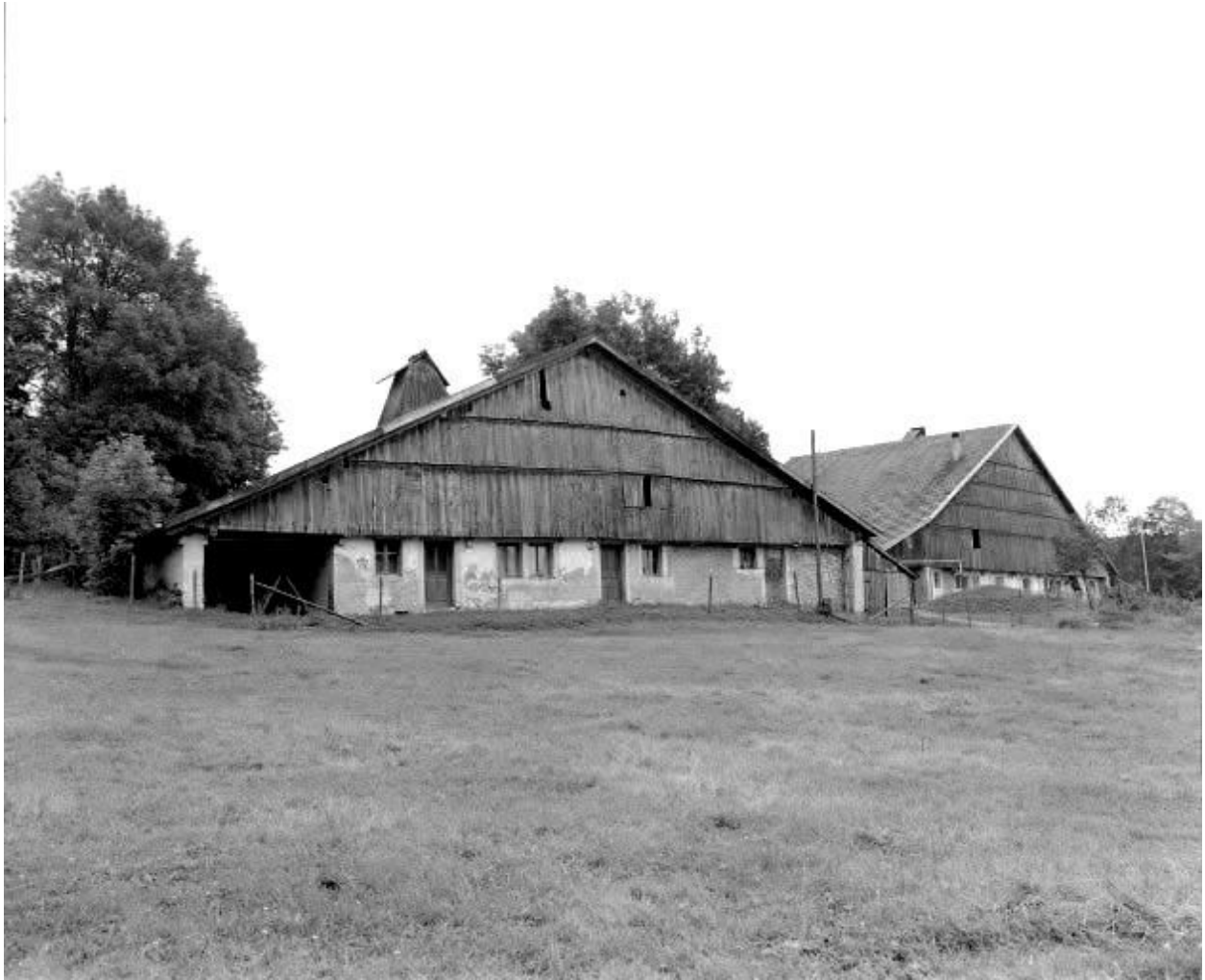
Fermes 1 et 2 : façades antérieures.
