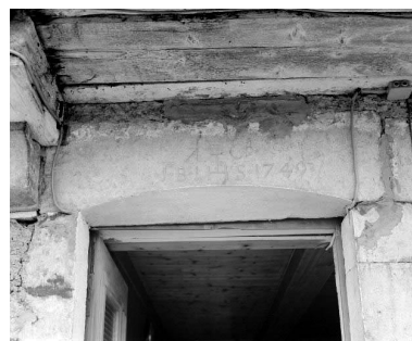
Ferme 2 : linteau de la porte d'entrée. Phot. Yves Sancey IVR43_19772500404X
