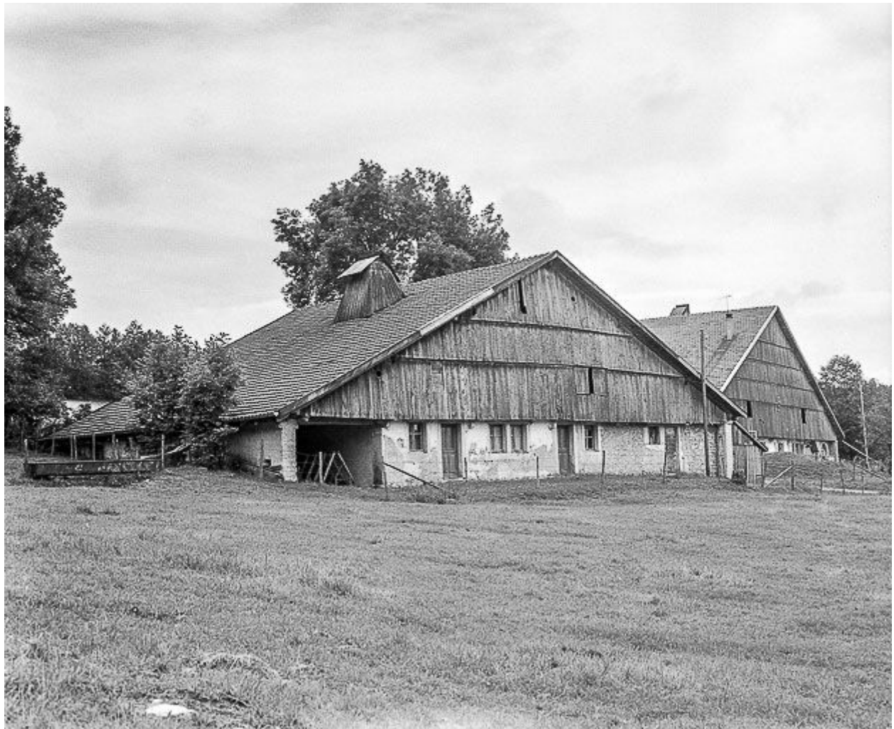
Fermes 1 et 2 : façades antérieures.
