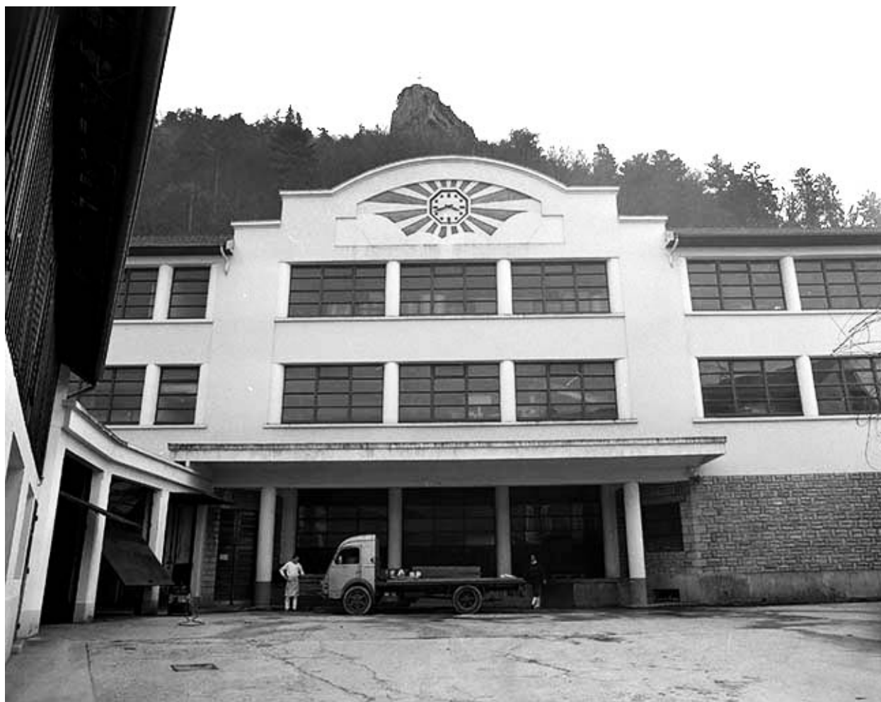
Atelier de fabrication : fronton de la façade.
