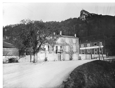
[Vue d'ensemble de la brasserie Dubouloz]. Phot. Jérôme Mongreville IVR43_19963901183X
