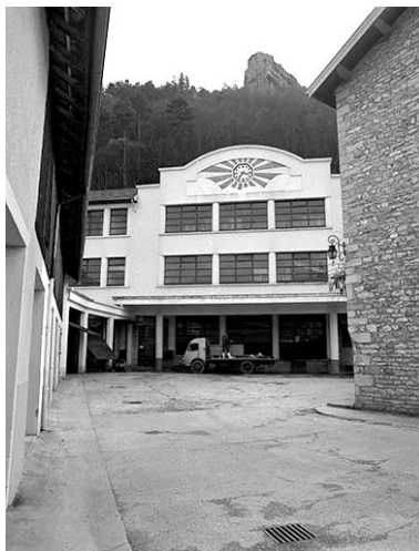
L'atelier de fabrication depuis l'entrée. Phot. Yves Sancey IVR43_19973900477X
