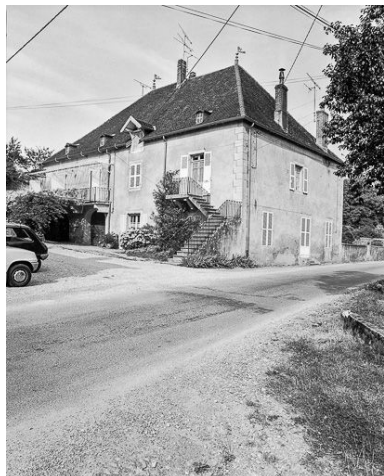
Façades antérieure et latérale droite.
