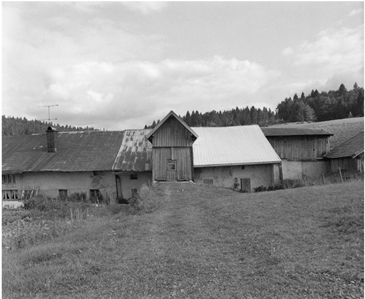
Façade postérieure avec pont de grange.
