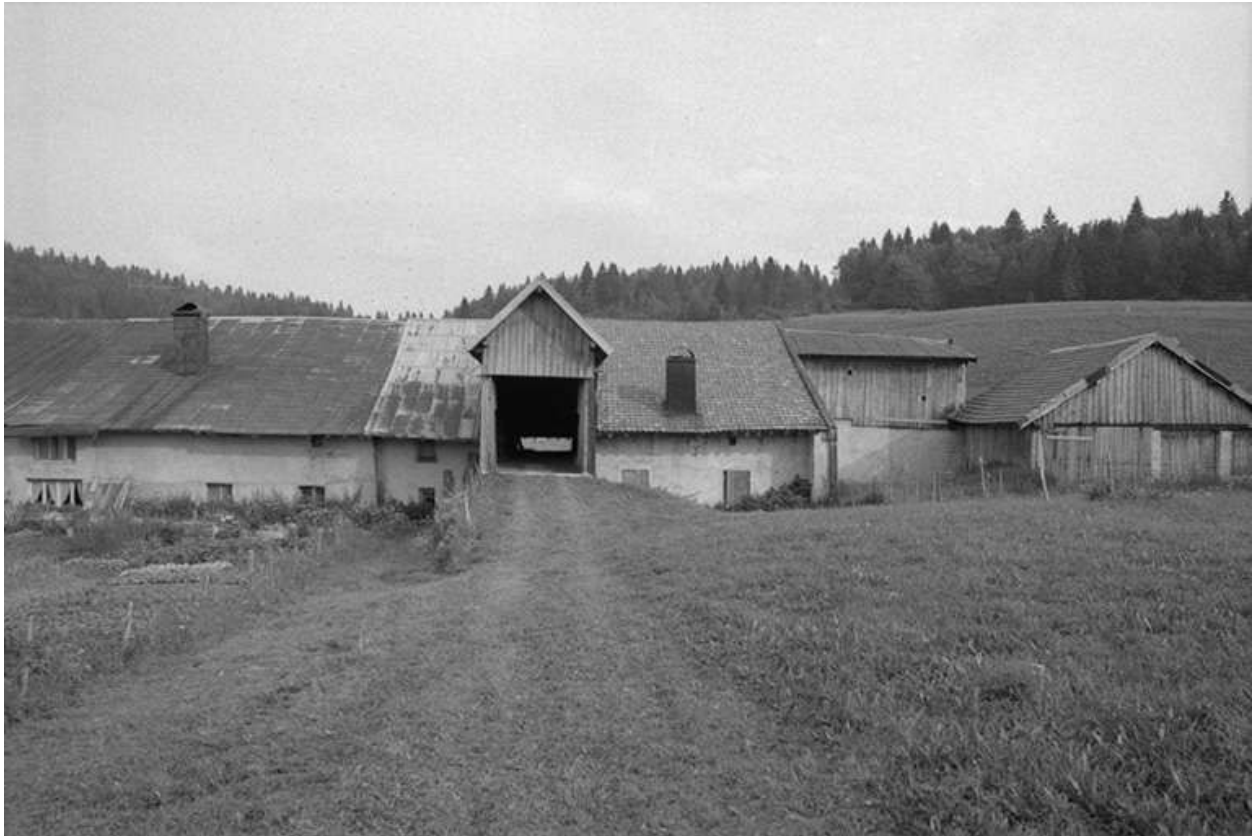
Façade postérieure avec pont de grange.
