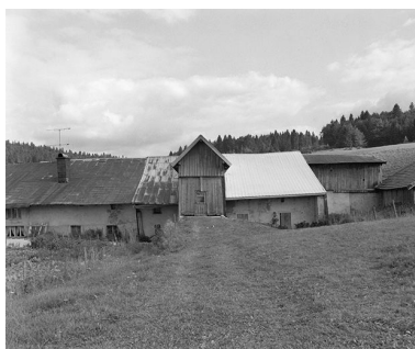
Façade postérieure avec pont de grange. Phot. Yves Sancey IVR43_19782500490X
