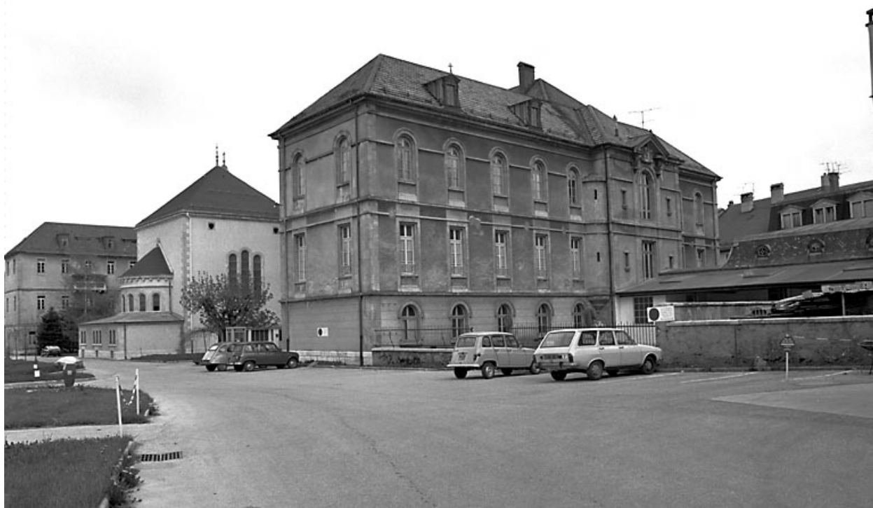
Façade postérieure, vue d'ensemble de trois quarts.
