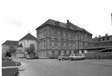
Façade postérieure, vue d'ensemble de trois quarts. Phot. Yves Sancey IVR43_19802501429X
