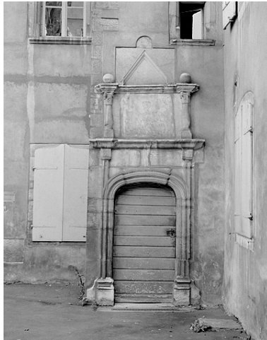
Porte de la tour d'escalier. Phot. Jérôme Mongreville IVR43_19872500529X
