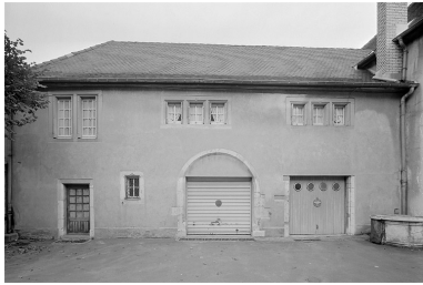
Aile gauche. Façade sur la cour. Phot. Jérôme Mongreville IVR43_19872501065V
