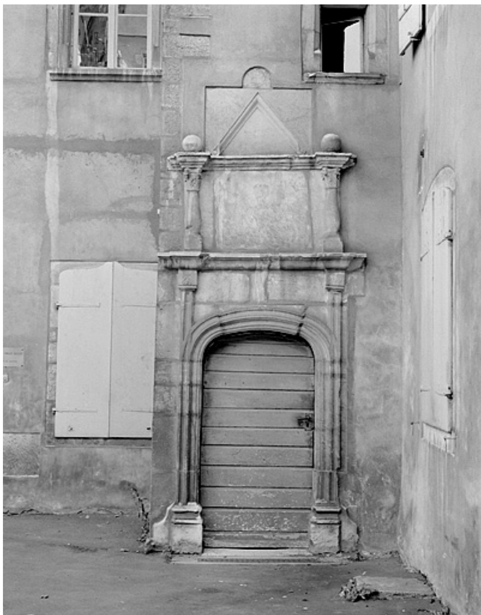
Porte de la tour d'escalier.
