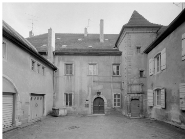
Vue d'ensemble de la cour. Phot. Jérôme Mongreville IVR43_19872501162V
