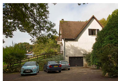
Façade latérale droite. Phot. Sonia Dourlot IVR43_20142501409NUC2A
