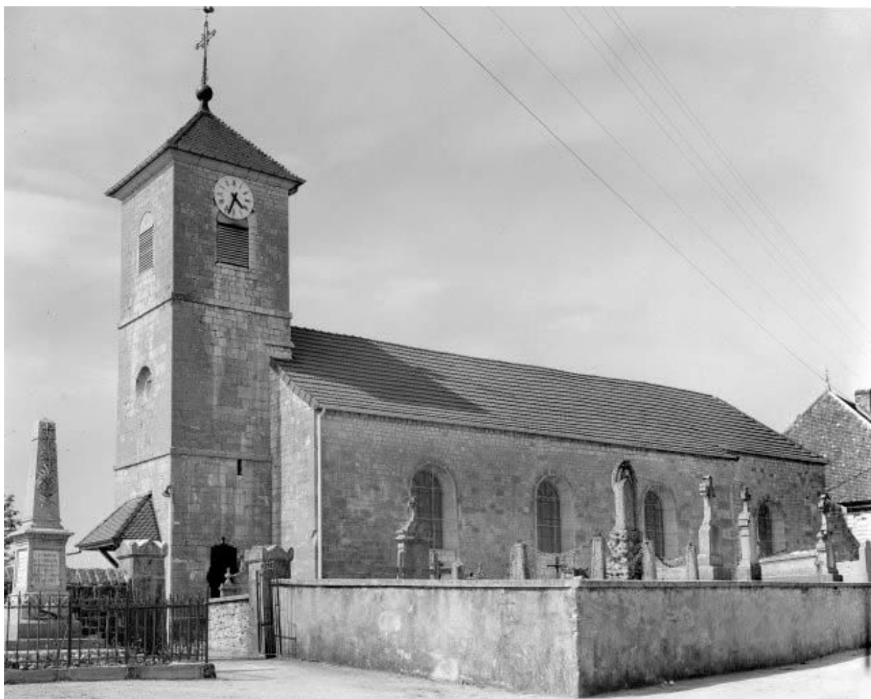
Façades antérieure et latérale droite.
