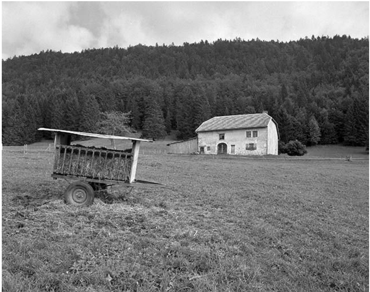
Façade antérieure, vue éloignée.
