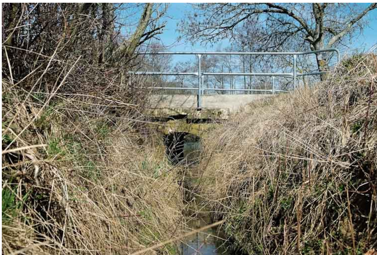
Ponceau, vue rapprochée.
