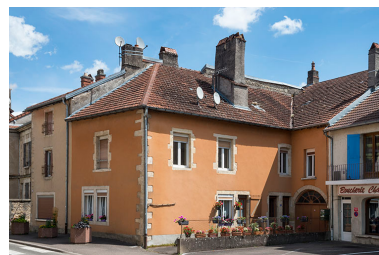
Élévation sur la rue Armand-Paulmard. Phot. Jérôme Mongreville IVR43_20187000441NUC4A
