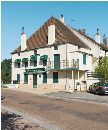
Vue d'ensemble du café. Phot. Pierre-Marie Barbe-Richaud IVR26_20177100373NUC2A
