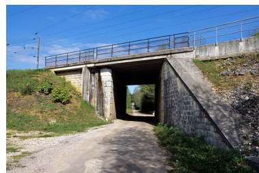
Vue d'ensemble. Phot. Yves Sancey IVR43_20053900022ZA
