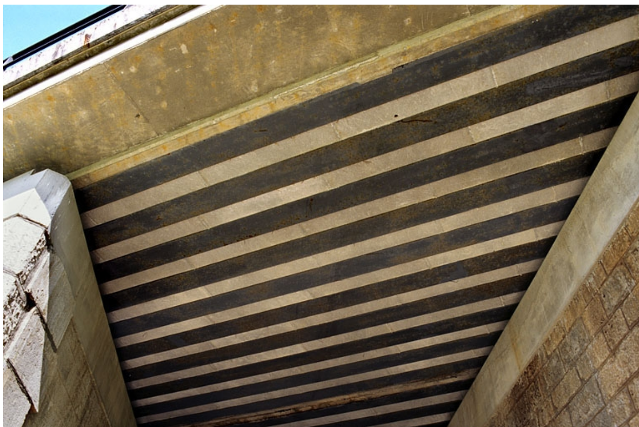
Face inférieure du tablier : poutrelles enrobées.
