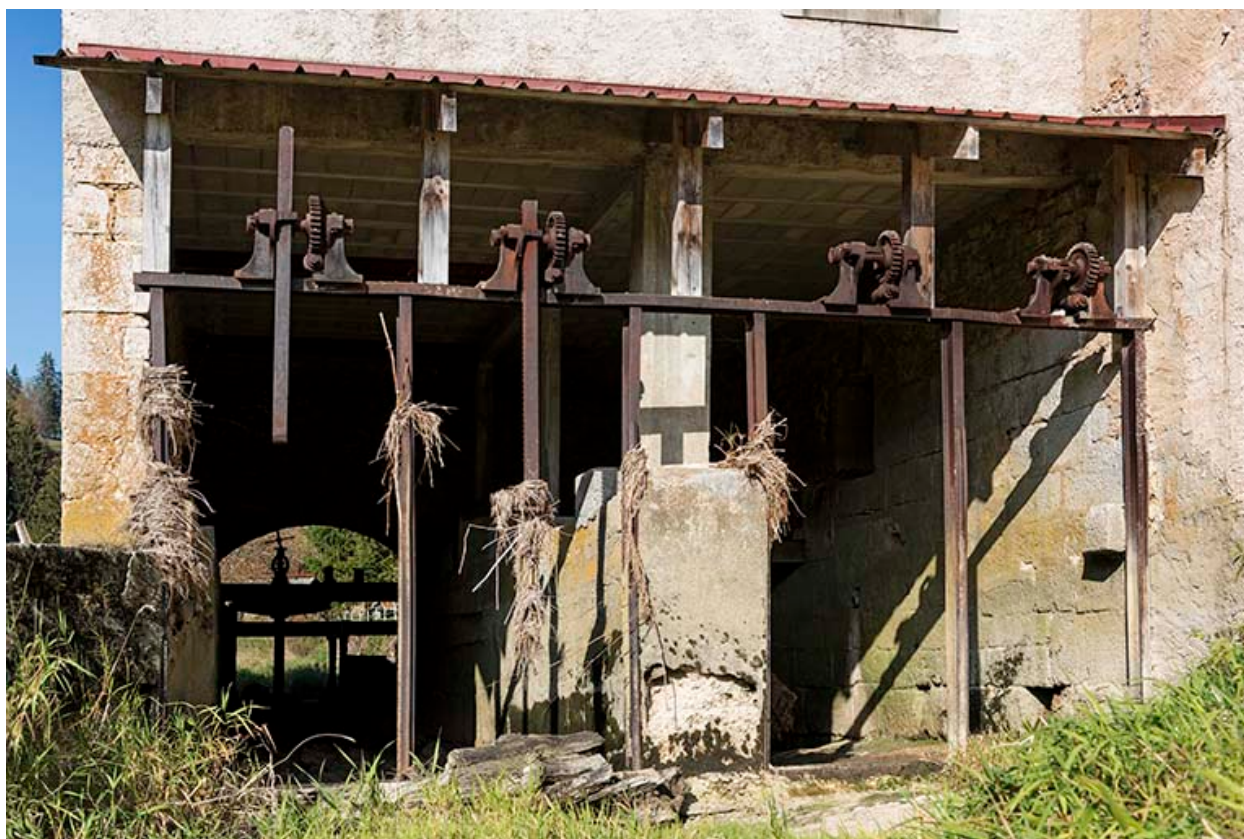
Moulin : vestiges des vannes de prise d'eau.
