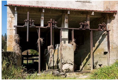
Moulin : vestiges des vannes de prise d'eau. Phot. Sonia Dourlot IVR43_20182501763NUC4A
