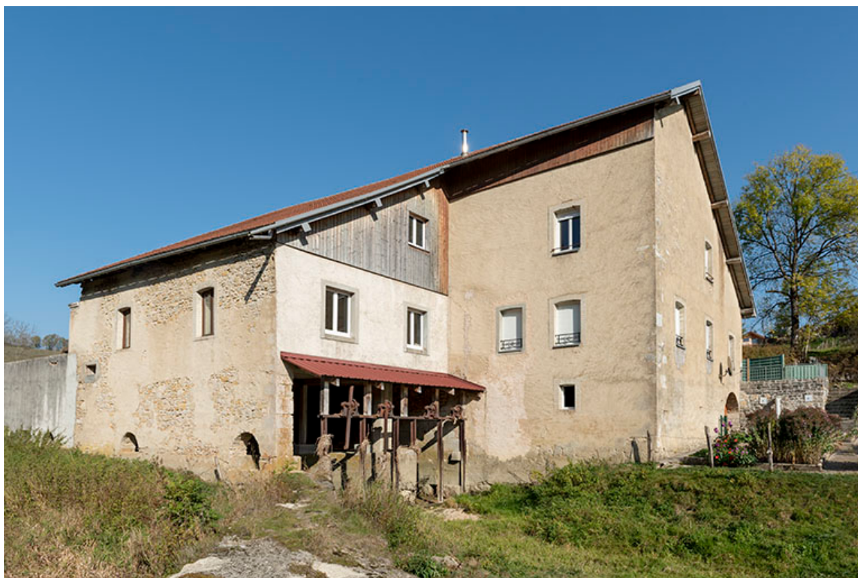
Moulin : façades postérieure et latérale gauche.
