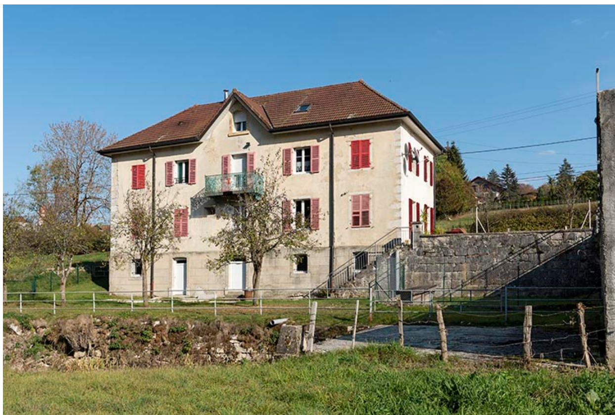
Maison : façade postérieure.
