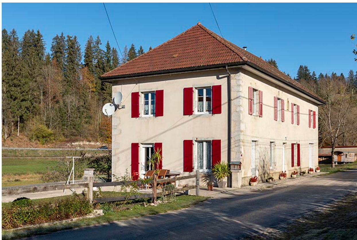
Maison : façades antérieure et latérale gauche.
