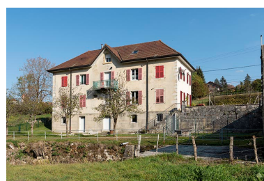
Maison : façade postérieure. Phot. Sonia Dourlot IVR43_20182501757NUC4A
