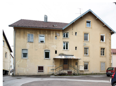
Bâtiment sur rue : façade postérieure. Phot. Sonia Dourlot IVR43_20182500911NUC4A
