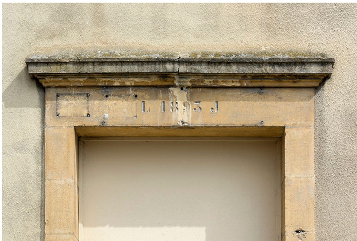
Bâtiment sur rue : linteau daté 1893.
