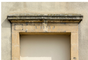
Bâtiment sur rue : linteau daté 1893. Phot. Sonia Dourlot IVR43_20182500912NUC4A
