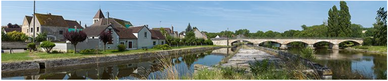
L'embranchement de Vermenton au niveau du village d'Accolay. A droite, la Cure. Vue depuis la digue.
