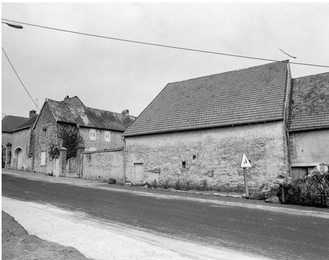
Ferme située rue 7 Grande Rue.
