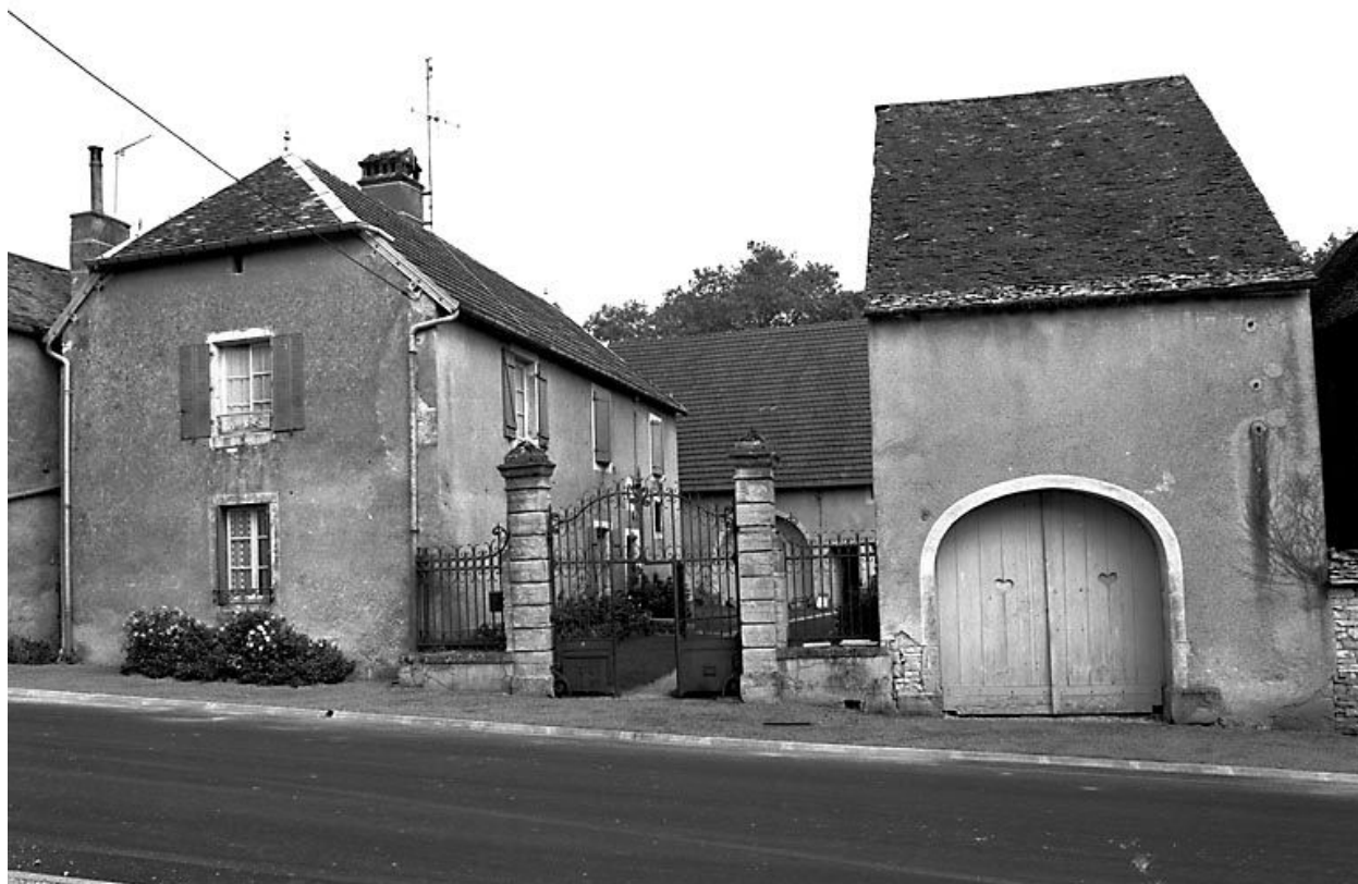
Ferme située rue 5 Grande Rue.
