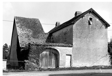
Ferme située rue 15 rue Saint-Joseph. Phot. Dominique Dominguez IVR43_19807000251X
