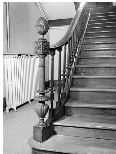
Banque. Escalier. Phot. Jérôme Mongreville IVR43_19872500926X
