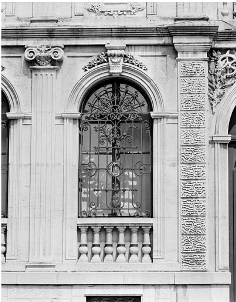
Banque. Façade principale, fenêtre du rez-de-chaussée.
