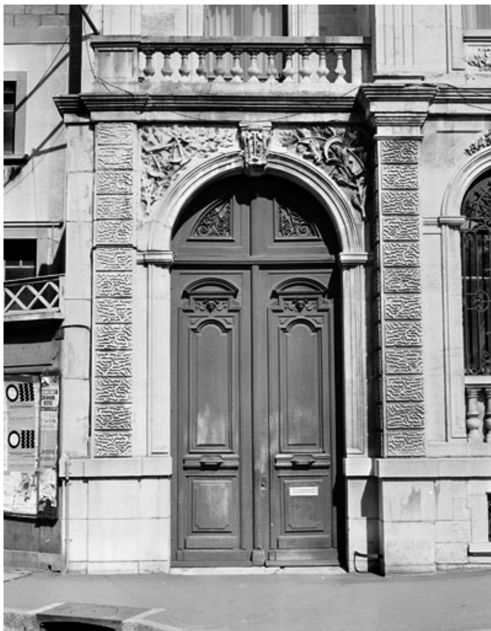
Banque. Façade principale, porte cochère.
