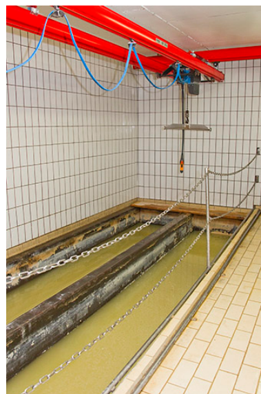
Bacs à saumure. Phot. Yves Sancey IVR43_20132501178NUC2A
