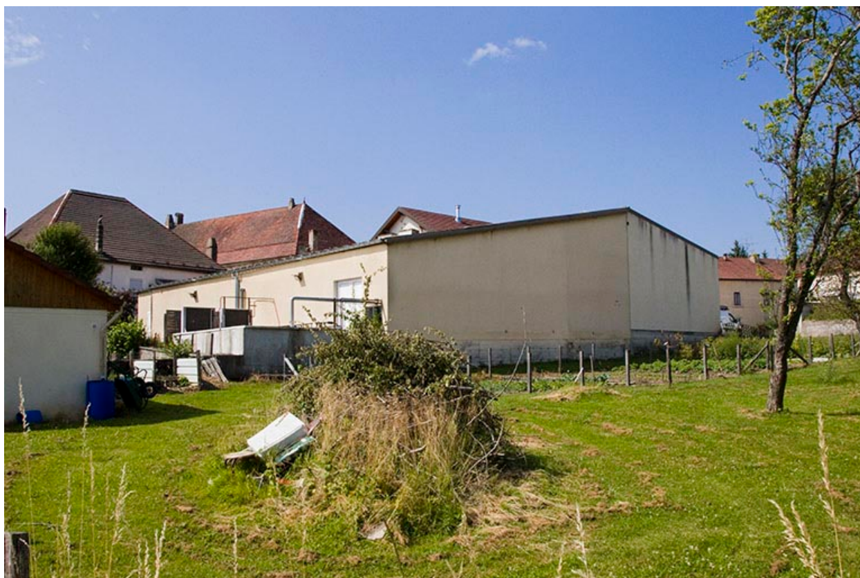
Façades postérieure et latérale gauche des extensions.
