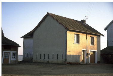
Fromagerie vue du nord. Phot. Laurent Poupard IVR43_19893900020ZA
