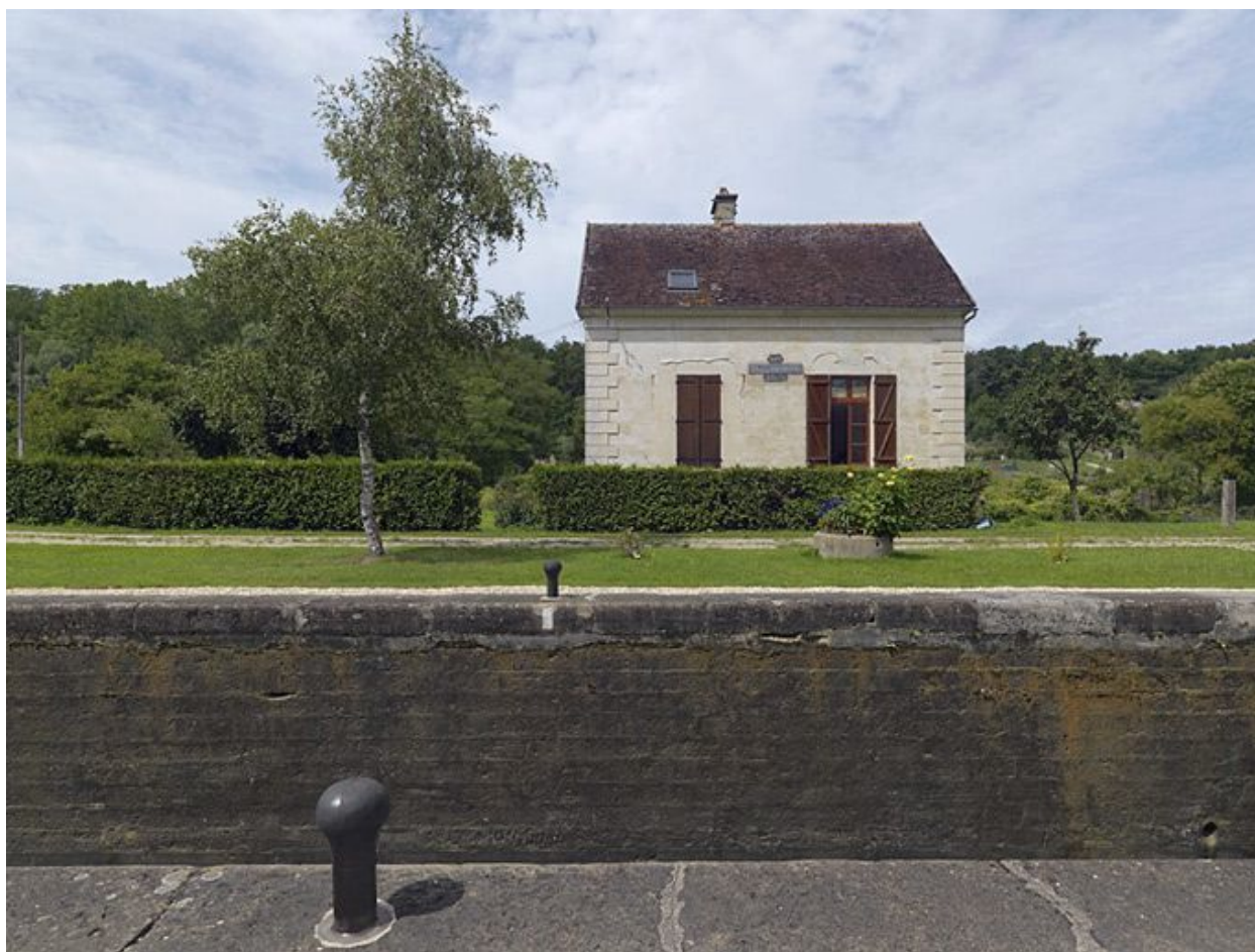
Maison éclusière : mur gouttereau sur canal.
