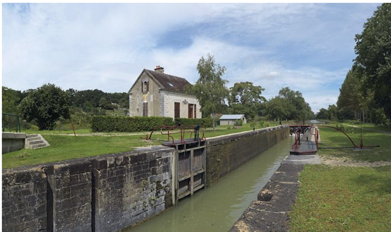
Site vu d'aval.
