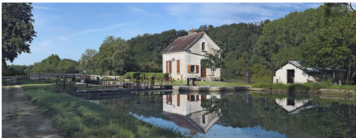
Vue d'ensemble du site pris d'amont.
