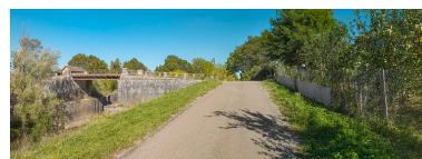
Le site d'écluse vu d'aval ; à droite, se trouve la maison éclusière. Phot. Thierry Kuntz IVR26_20197100491NUC4A
