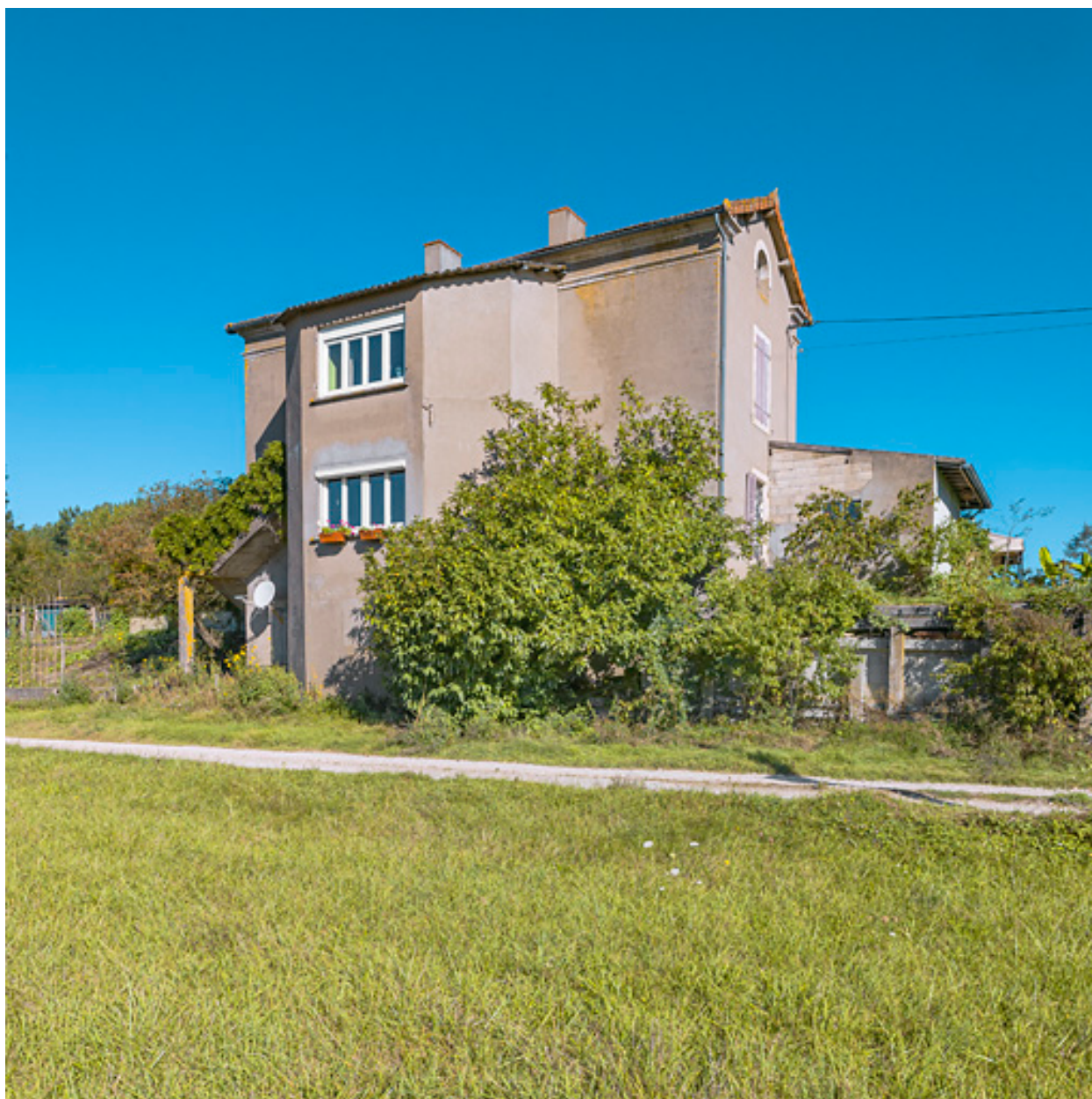
Façade arrière avec l'ajout d'un avant-corps central.
