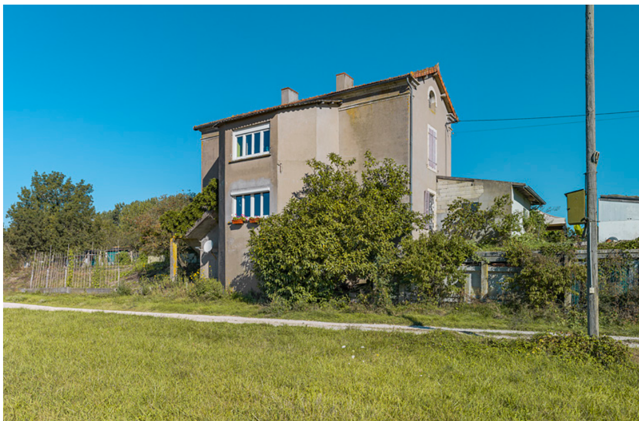
Façade arrière avec l'ajout d'un avant-corps central.
