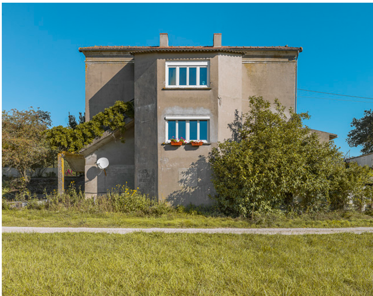
Façade arrière avec l'ajout d'un avant-corps central.
