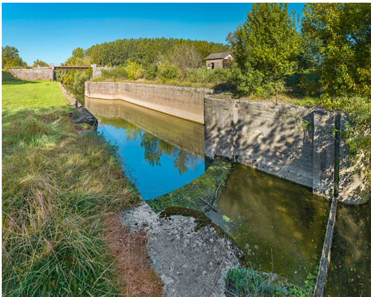
Le sas et l'emplacement des portes.
