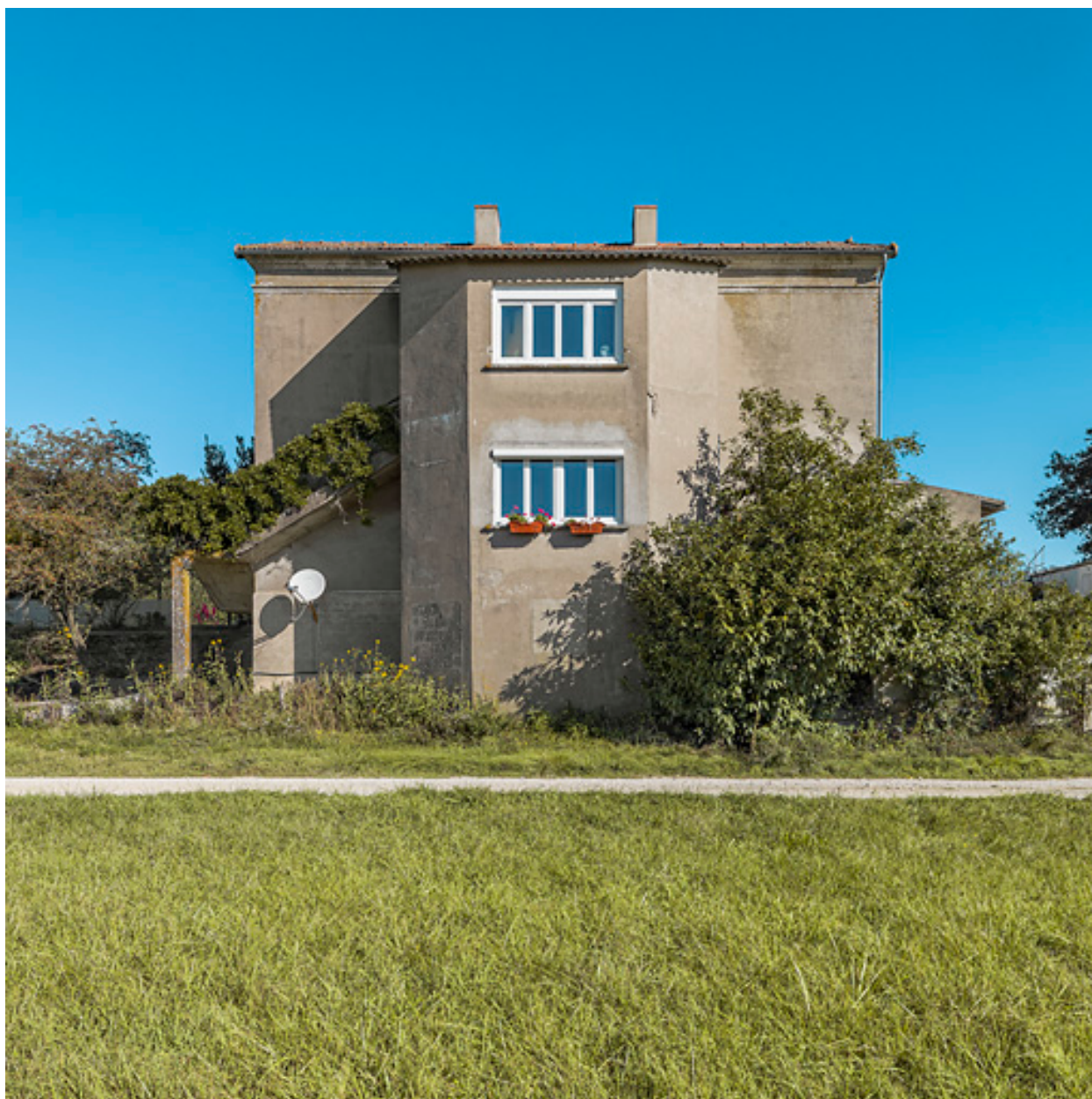
Façade arrière avec l'ajout d'un avant-corps central.
