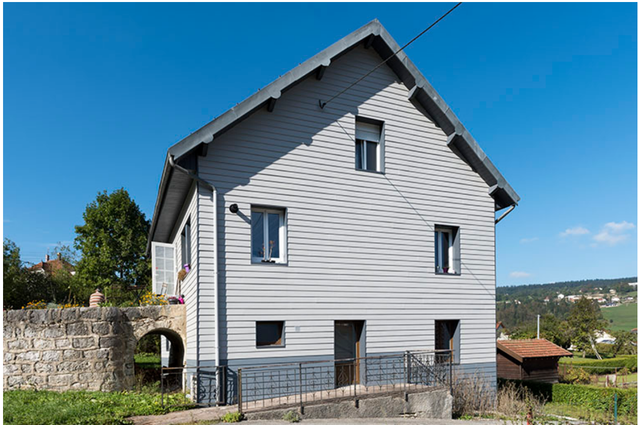
Façade latérale droite.
