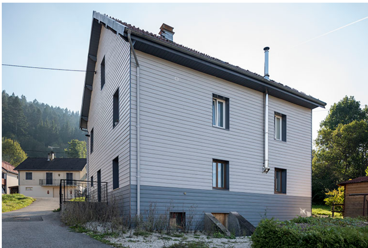
Façades postérieure et latérale droite.
