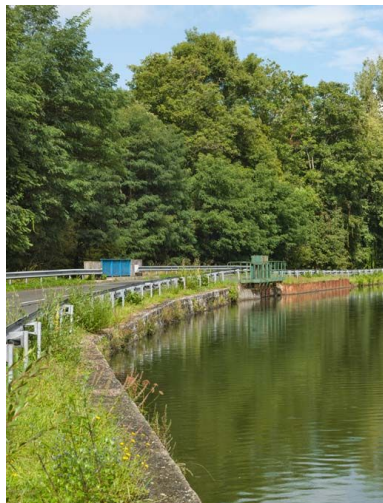
Vue de l'aqueduc et du déversoir à trois vannes.
