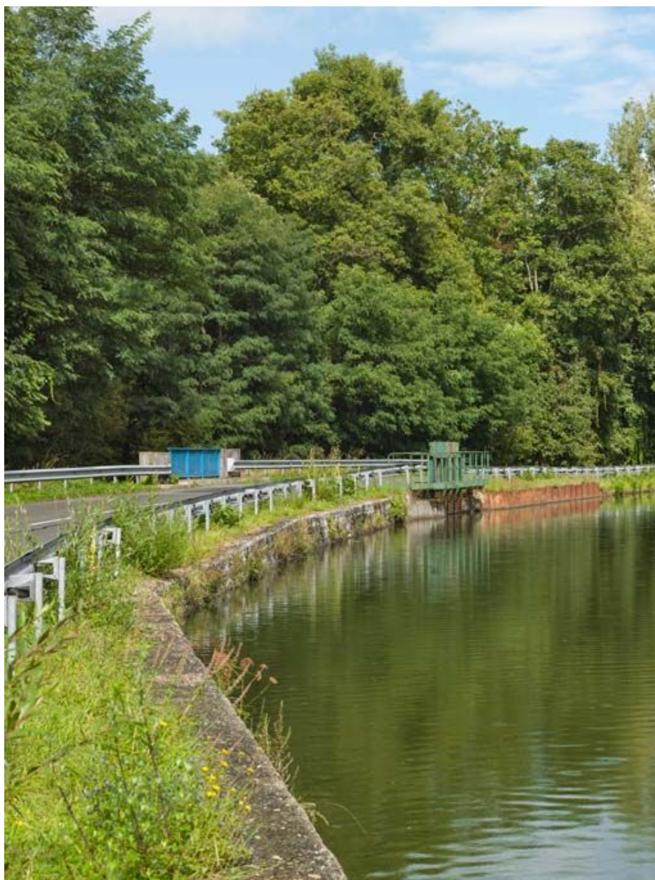
Vue de l'aqueduc et du d  versoir    trois vannes.
