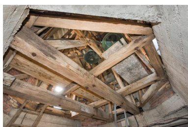
Enrayure de charpente du clocher. Vue en contre-plongée. Phot. Pierre-Marie Barbe-Richaud IVR26_20238901171NUC4A
