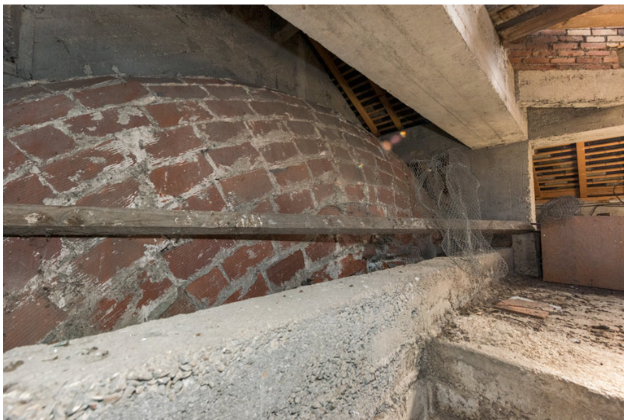
Voûte et charpente.
