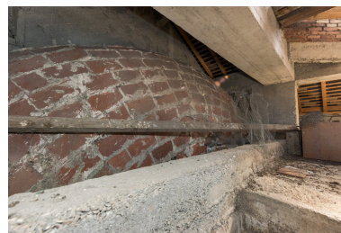
Voûte et charpente. Phot. Pierre-Marie Barbe-Richaud IVR26_20238901170NUC4A
