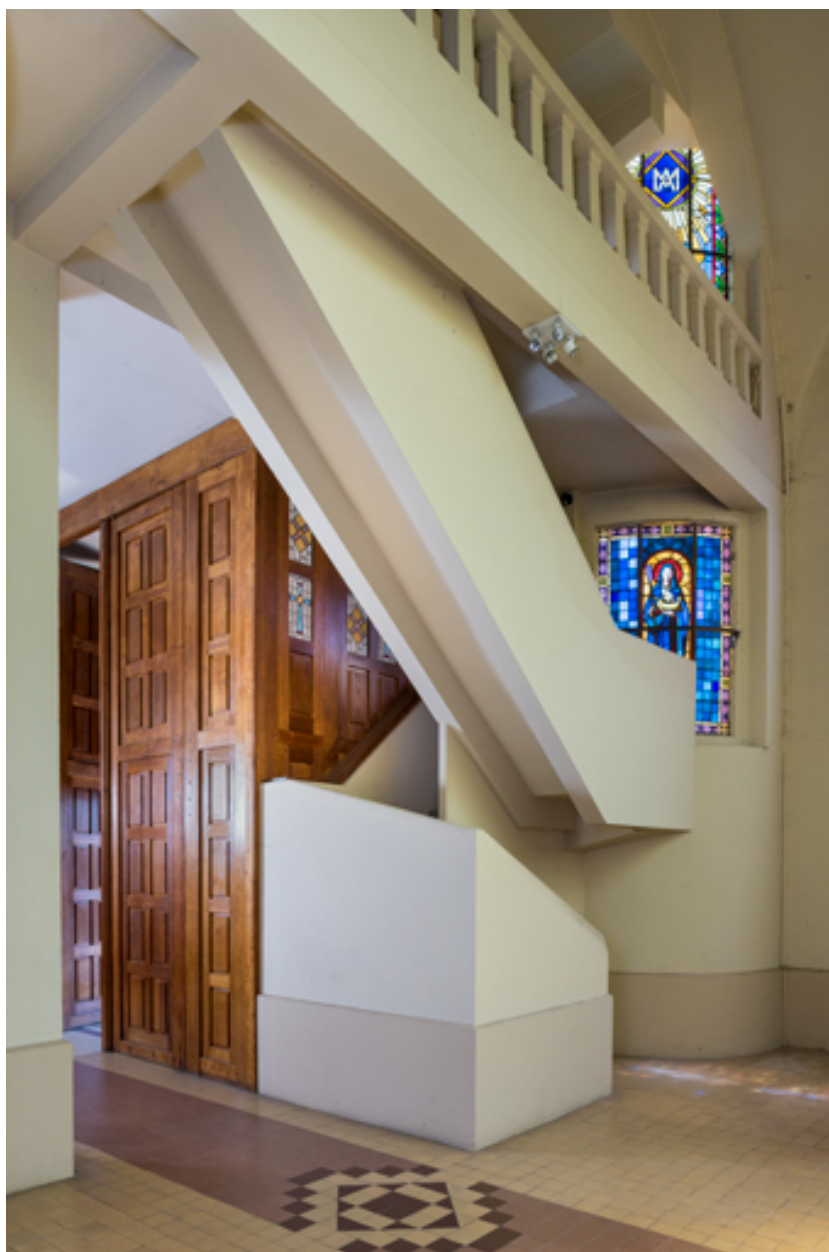
Escalier menant à la tribune sud.
