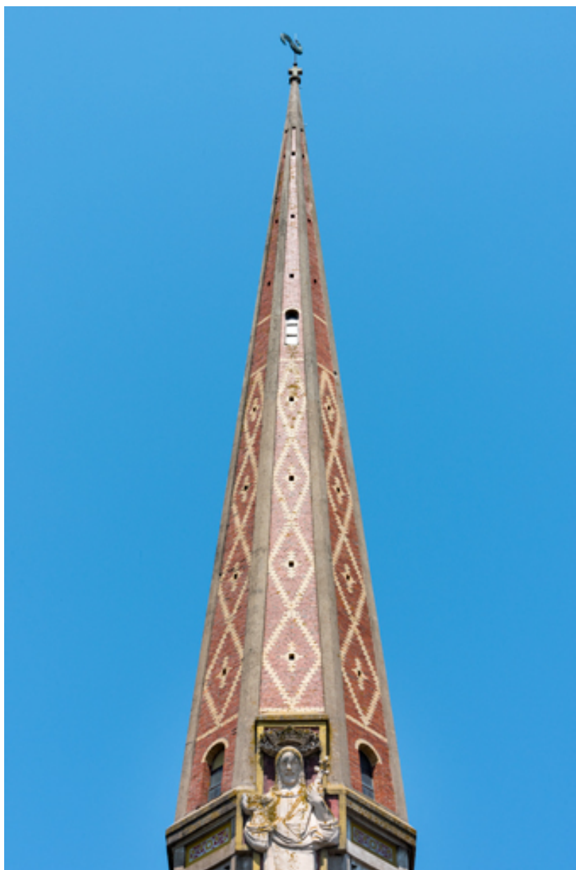
Toiture du clocher. Vue d'ensemble.
