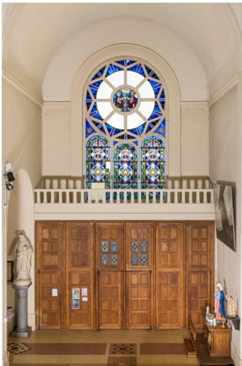
Bras gauche du transept. Vue d'ensemble.
