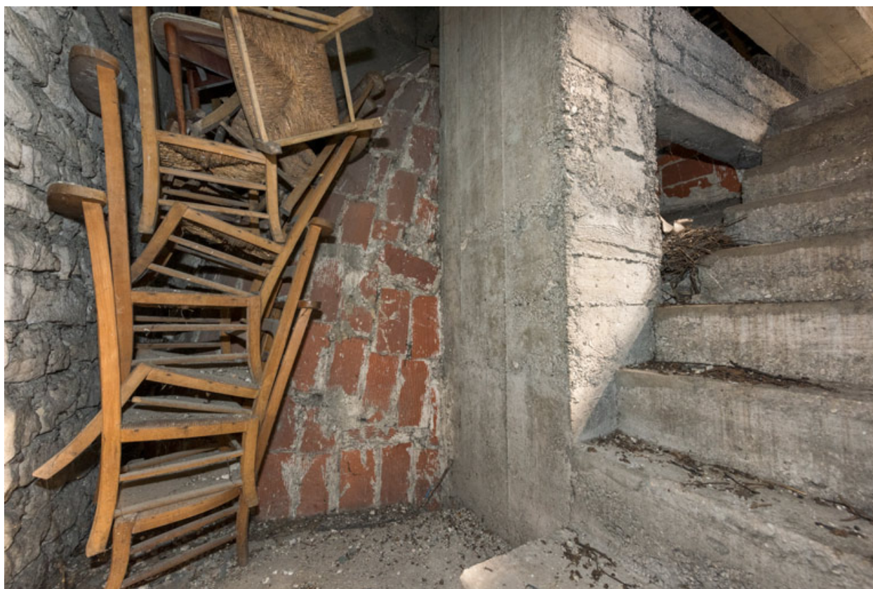
Voûte et escalier du clocher.
