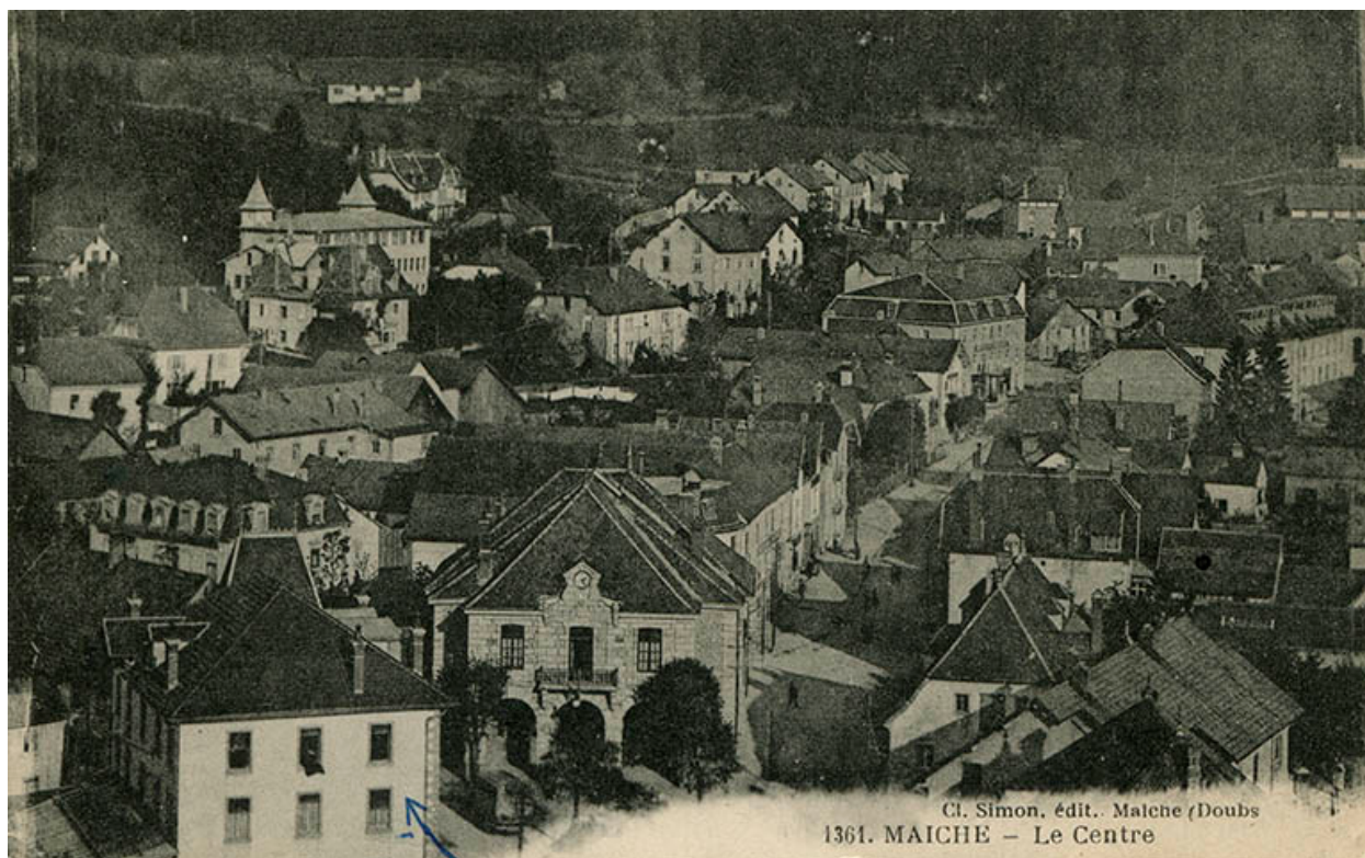
1361. Maîche - Le centre [vu depuis le clocher de l'église], 1ère moitié 20e siècle.
