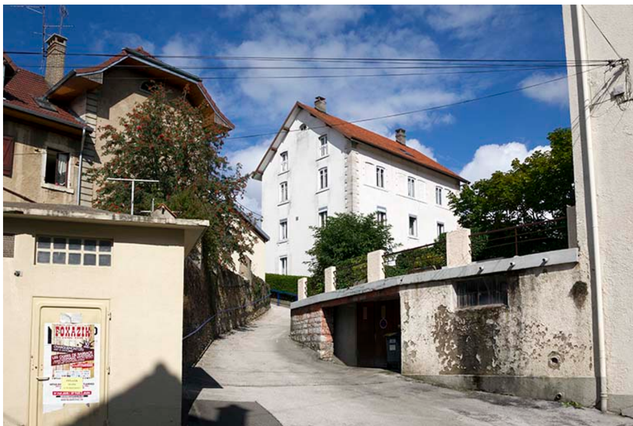
Façades postérieure et latérale droite.
