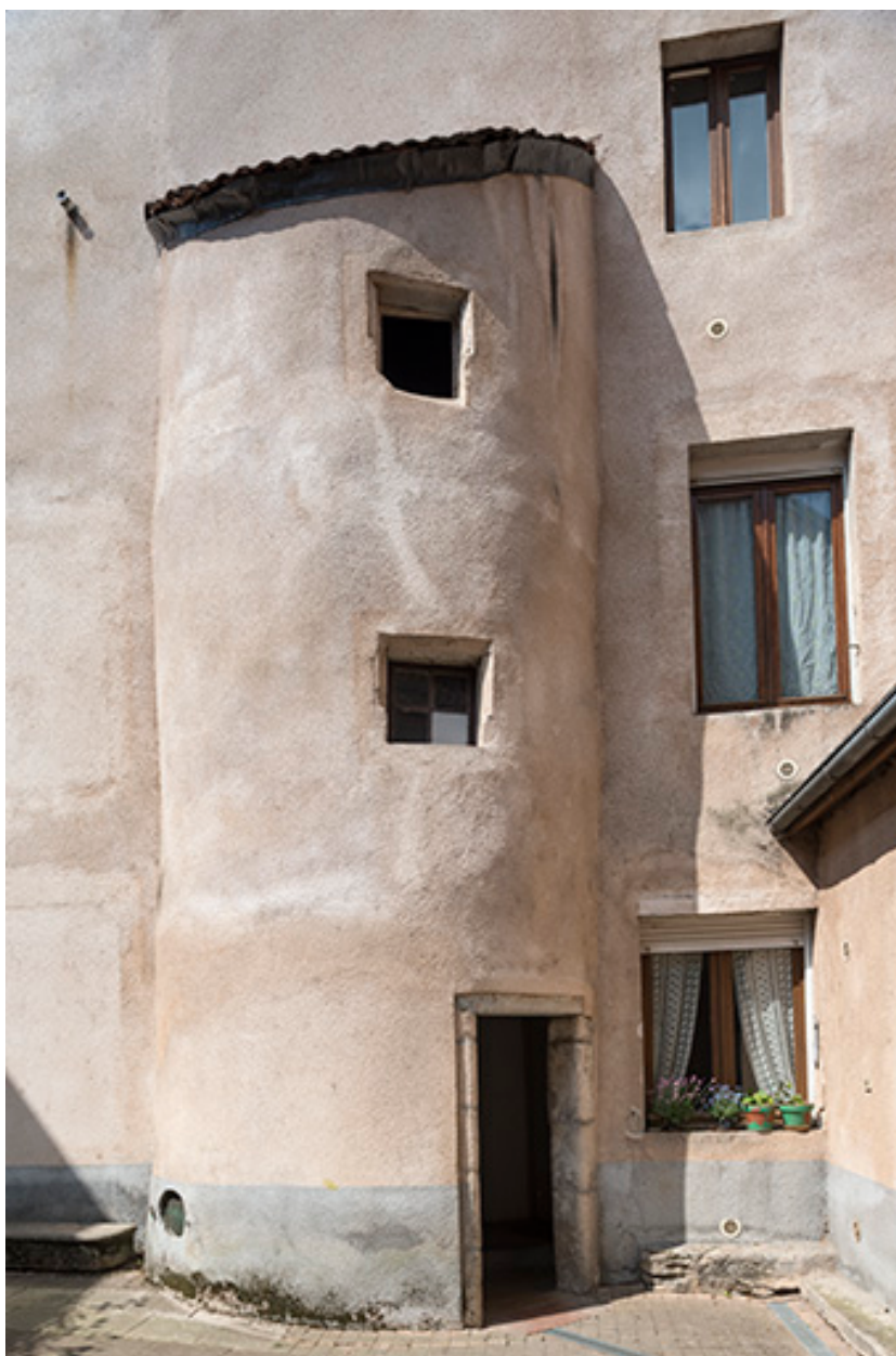
Tour comprenant un escalier, cour intérieure.
