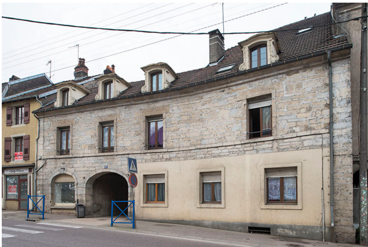
La façade principale depuis la rue.
