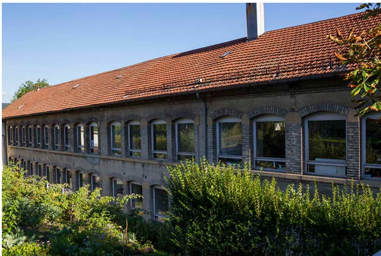
Aile nord : façade postérieure.
