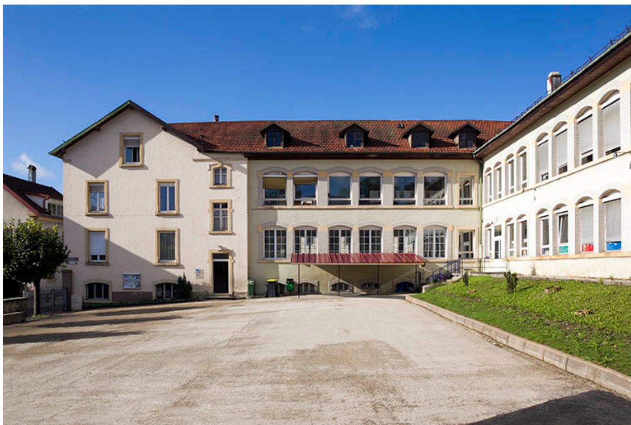
Aile ouest : façade orientale (sur cour).
