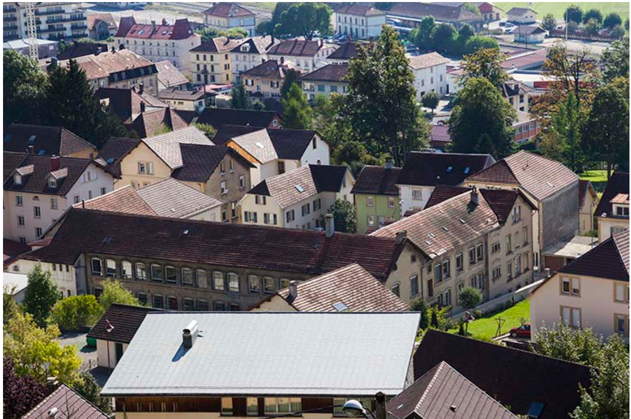
Vue d'ensemble plongeante, depuis le nord-ouest.
