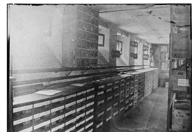
[Intérieur d'un magasin], [1902]. Phot. Sonia Dourlot IVR43_20182501620NUC4A
