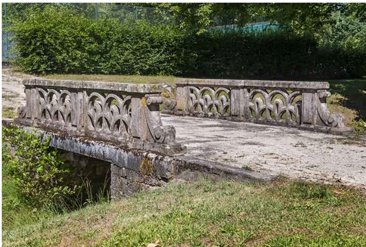
Pont à garde-corps en pierre.
