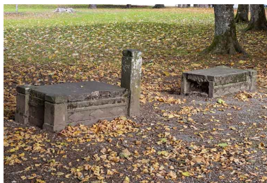
Pont des soupirs, vestiges. Phot. Jérôme Mongreville IVR43_20207000721NUC4A
