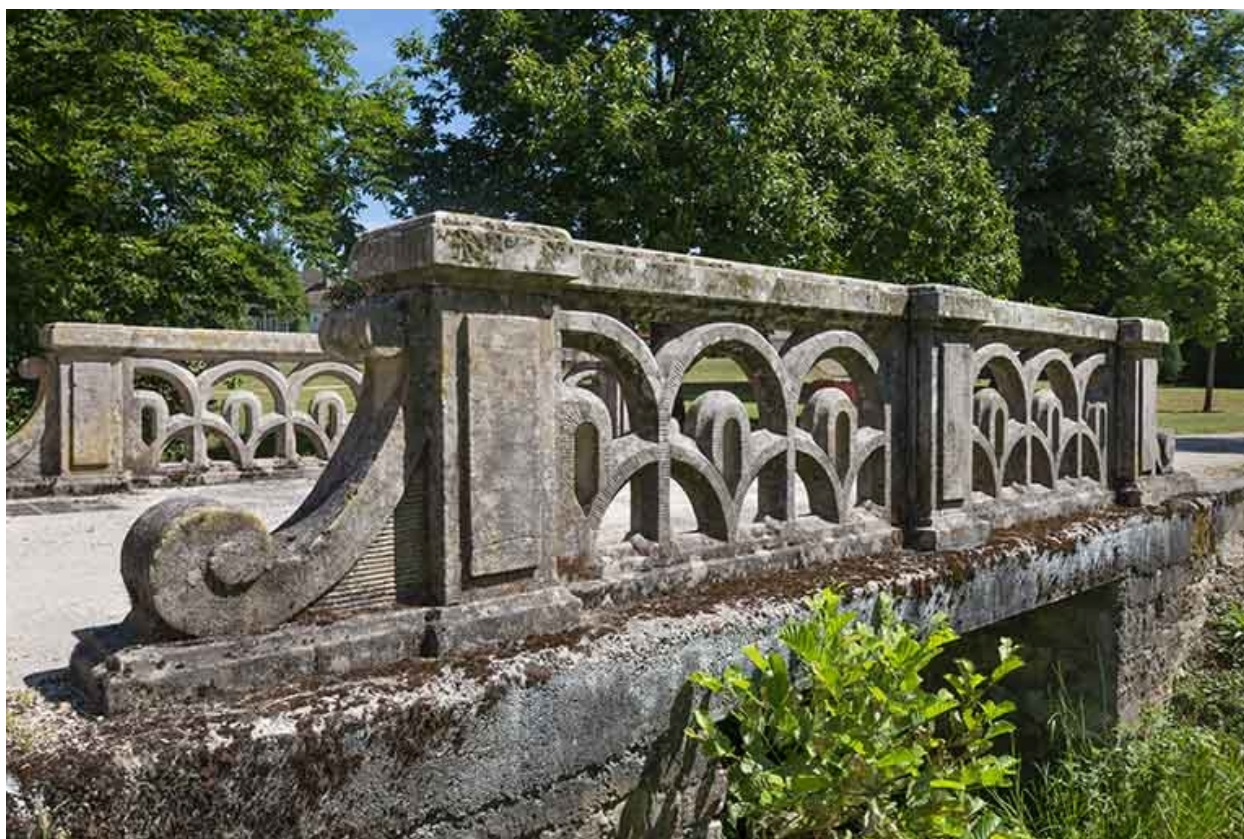
Pont à garde-corps en pierre.
