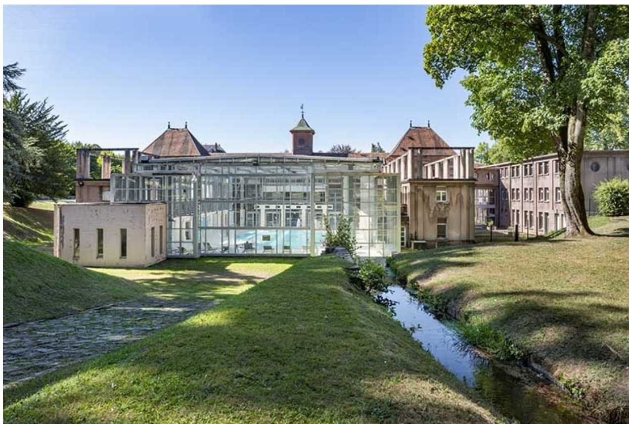
Vue en direction de l'établissement thermal.
