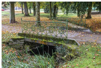
Pont à garde-corps en métal. Phot. Jérôme Mongreville IVR43_20207000711NUC4A
