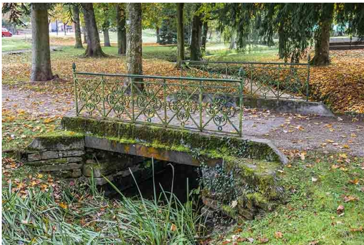
Pont à garde-corps en métal.
