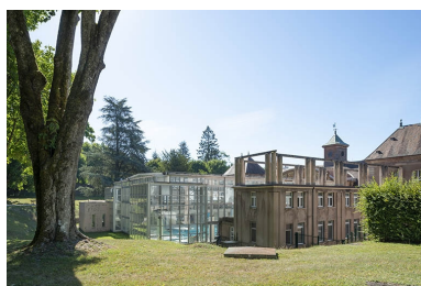
Vue en direction de l'établissement thermal. Phot. Jérôme Mongreville IVR43_20207000357NUC4A
