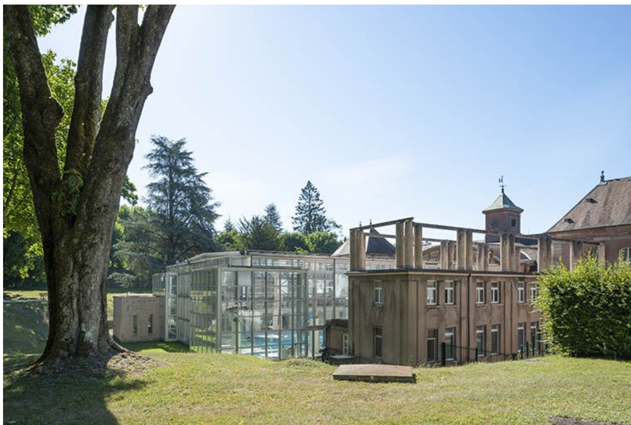
Vue en direction de l'établissement thermal.
