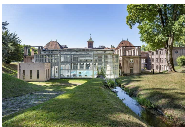
Vue en direction de l'établissement thermal. Phot. Jérôme Mongreville IVR43_20207000361NUC4A
