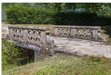
Pont à garde-corps en pierre. Phot. Jérôme Mongreville IVR43_20207000388NUC4A
