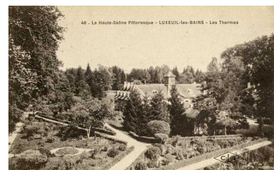
Vue d'ensemble depuis le nord. Autr. auteur inconnu IVR43_20217000073NUC4A
