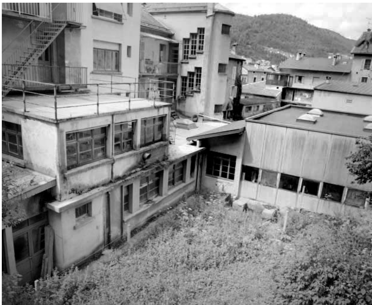
Ateliers de fabrication. Atelier de 1967 à droite.
