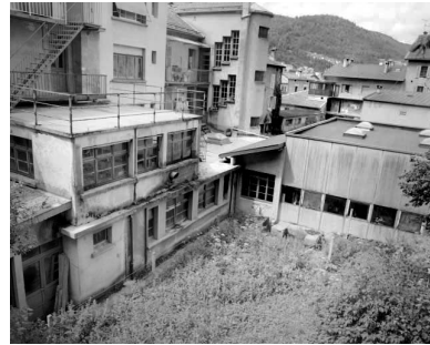
Ateliers de fabrication. Atelier de 1967 à droite. Phot. Jérôme Mongreville IVR43_19923900690X
