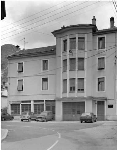
Extrémité nord de la façade antérieure. Phot. Jérôme Mongreville IVR43_19923900691V
