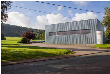
Entrée du site, au nord.
