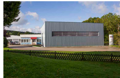
Façade antérieure (atelier de 2013 au premier plan).
