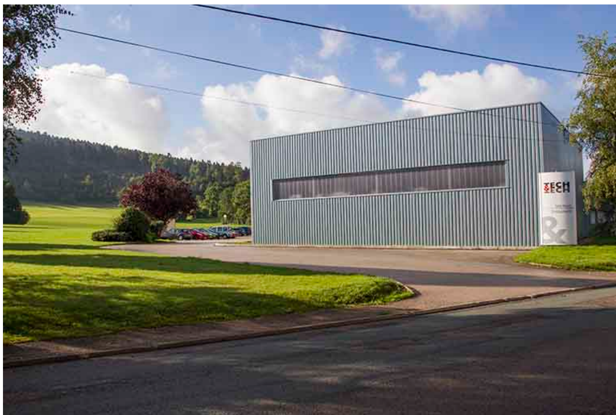
Entrée du site, au nord.
