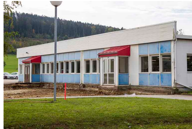
L'entrée, avant l'extension de 2013.
