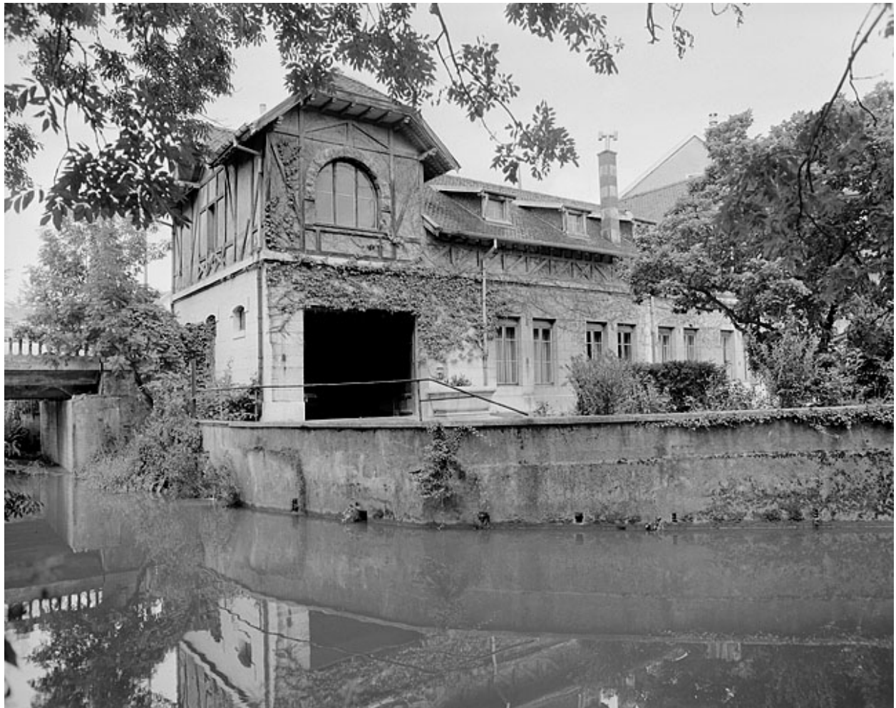
Partie méridionale des écuries et des remises.
