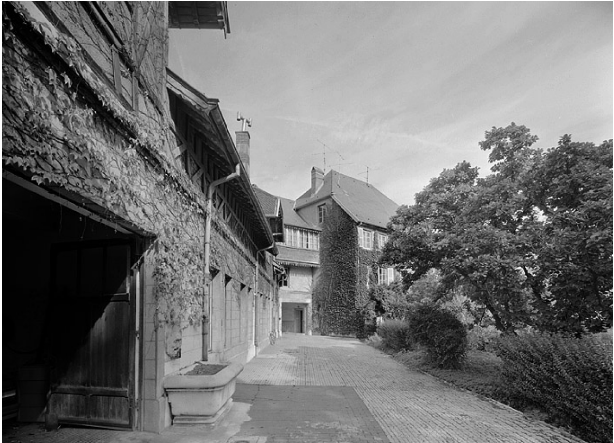
Cour des écuries et des remises.
