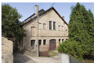
Vue sur le pignon oriental. Phot. Jérôme Mongreville IVR43_20067000646NUCA
