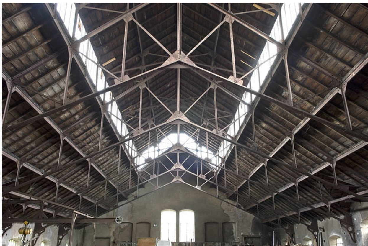
Vue de la charpente métallique.
