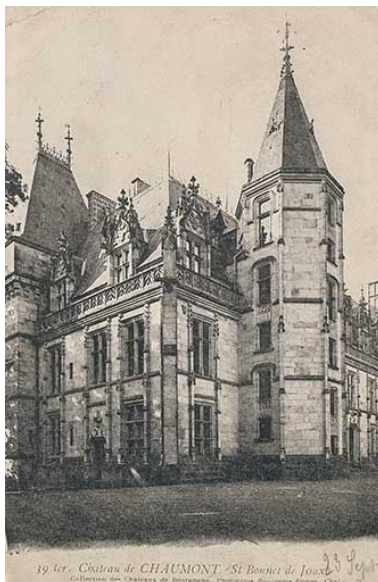
Vue ancienne, depuis le nord. Autr. auteur inconnu IVR26_20217100328NUC1A
