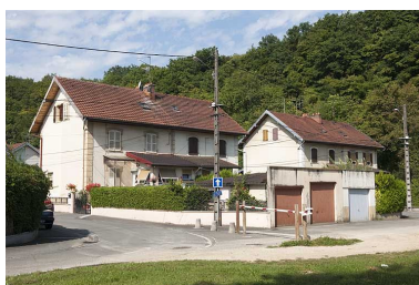
Habitations à 4 logements vues de trois quarts. Phot. Jérôme Mongreville IVR43_20112502014NUC4A
