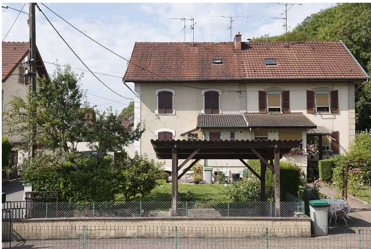
Face est d'une habitation à 4 logements.
