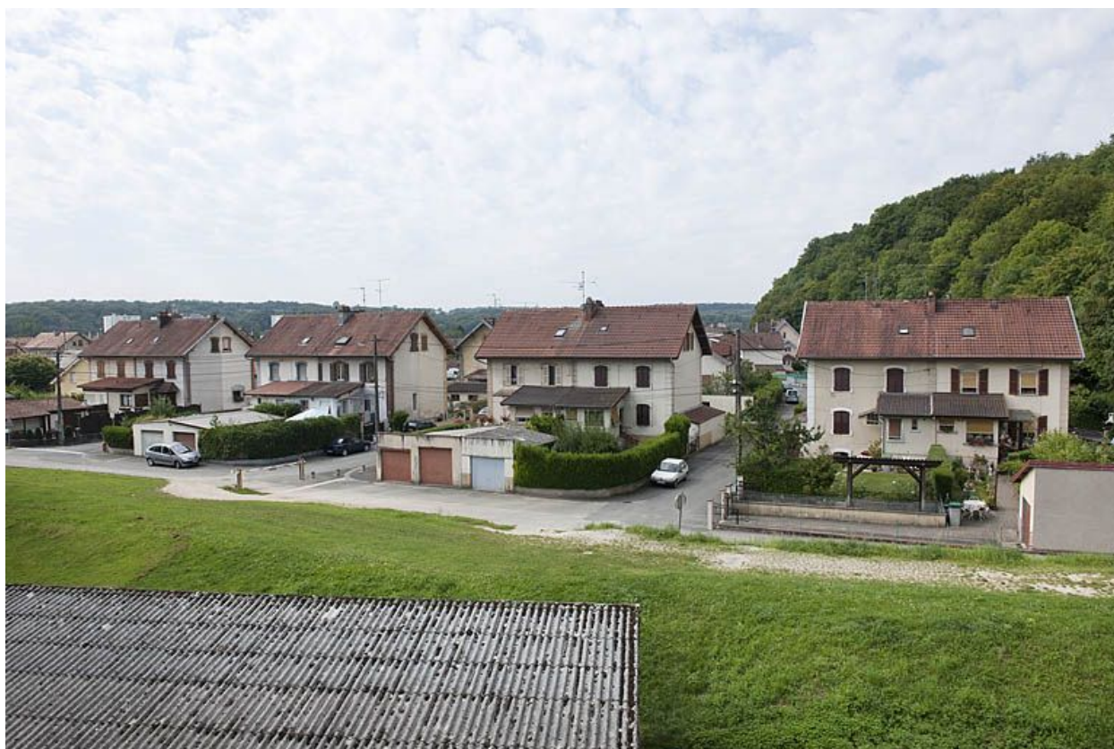
Vue d'ensemble depuis l'est.
