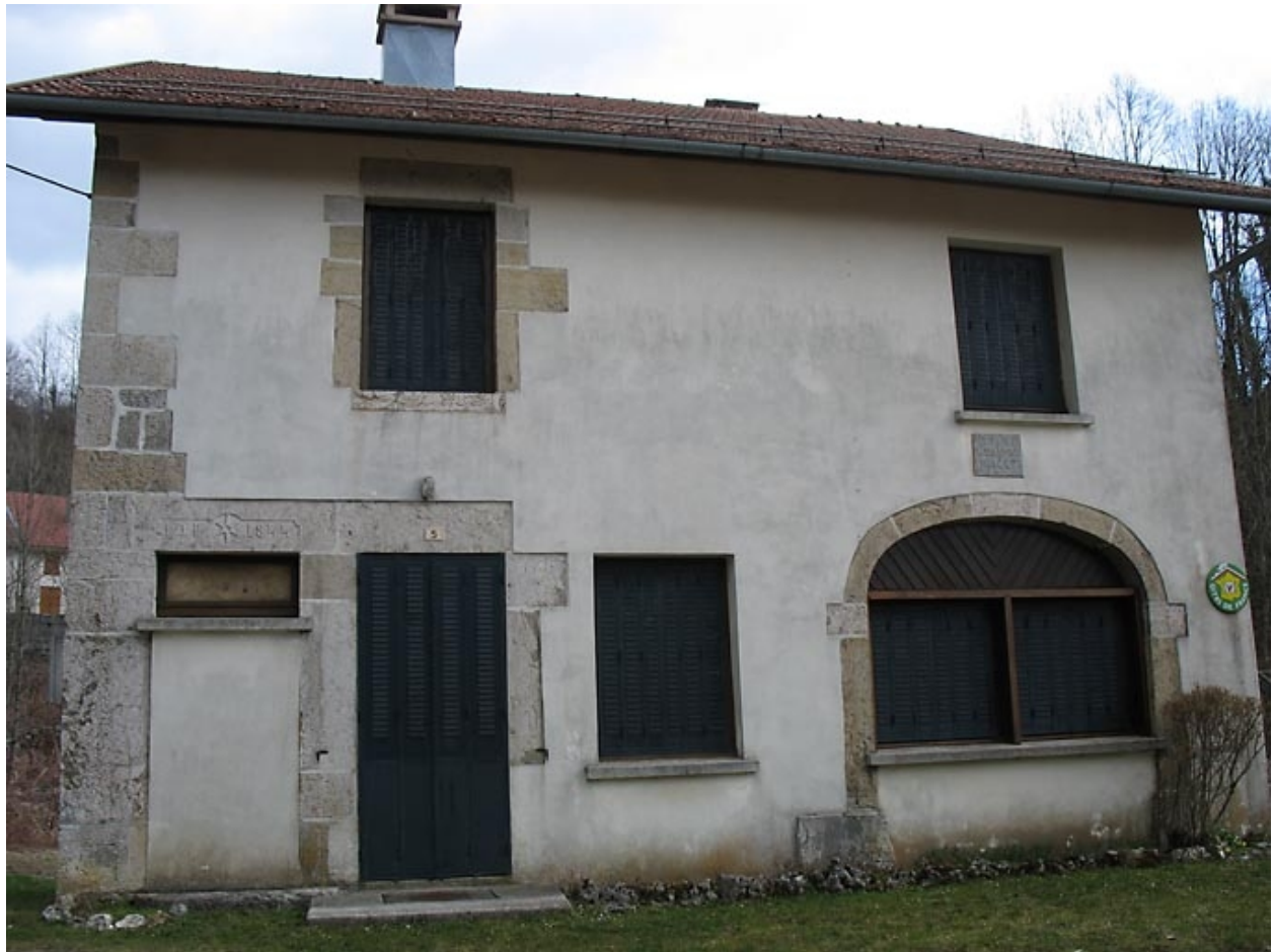
Vue générale sur façade antérieure.
