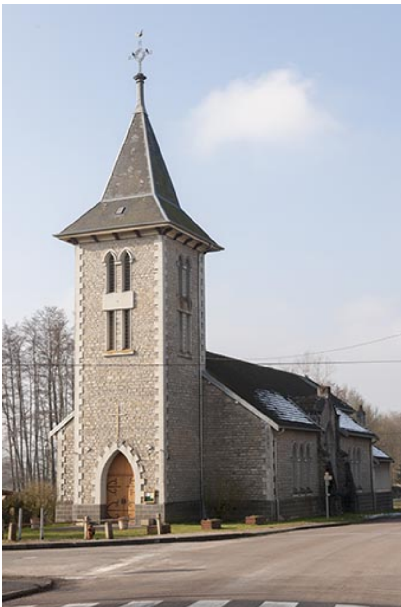
Façade antérieure, vue de trois quart droite.
