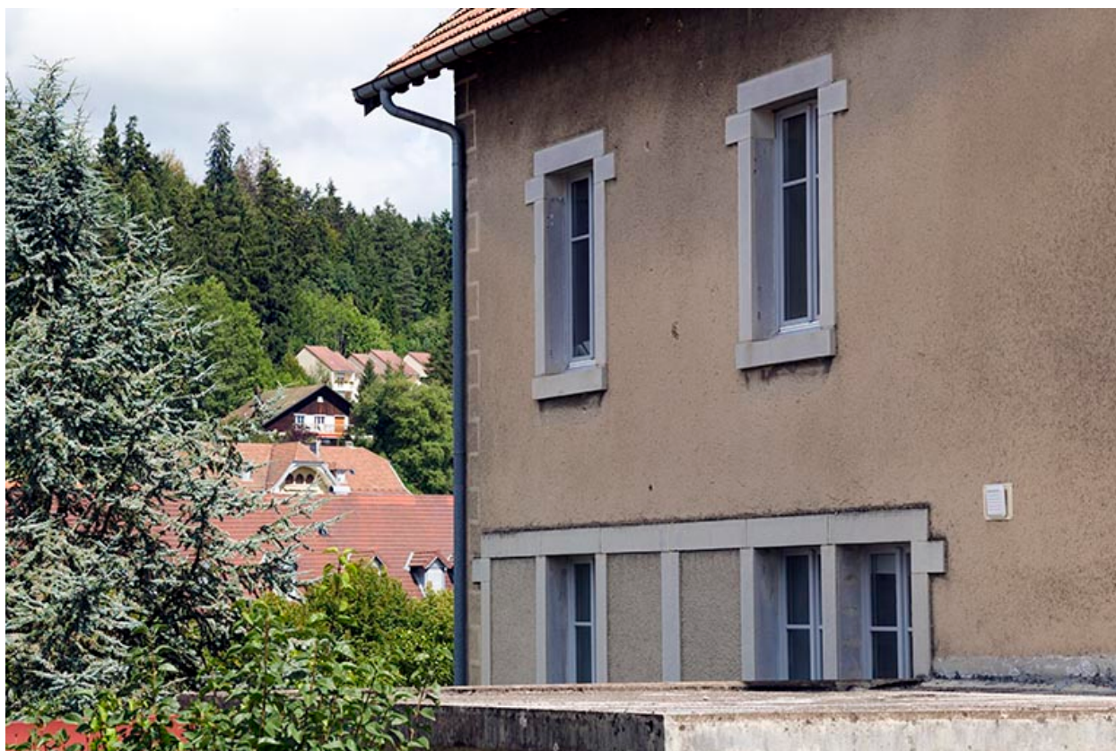
Façade latérale gauche : fenêtres multiples.
