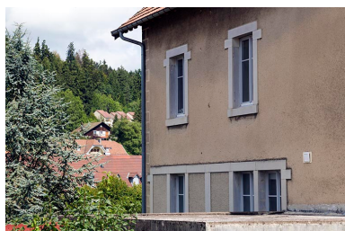
Façade latérale gauche : fenêtres multiples.
