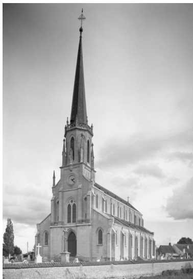
Elévations antérieure et droite Phot. Michel Thierry IVR26_19852101222V
