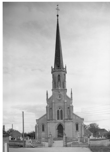
Elévation antérieure Phot. Michel Thierry IVR26_19852101221V
