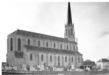
Elévation gauche Phot. Michel Thierry IVR26_19852101223V
