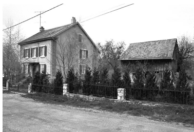
Maison du 19e siècle. Phot. Bernard Lardière IVR43_19829000235Z
