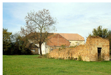
Logement d'ouvriers. Phot. Laurent Poupard IVR43_19883900670ZA
