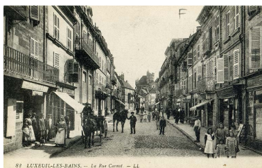
Rue Carnot, vue en direction du sud.
