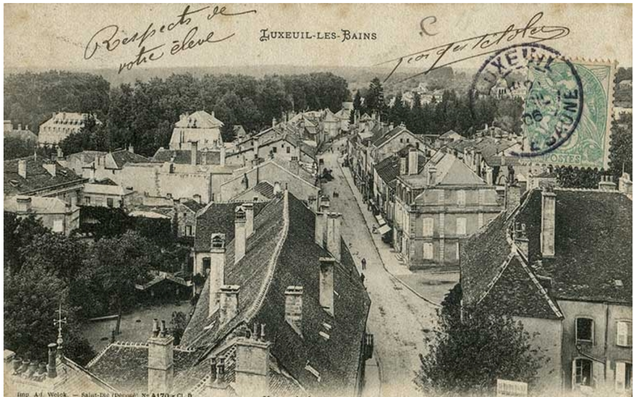
Rue Carnot, vue en direction du nord.
