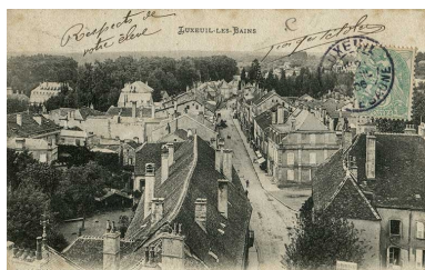
Rue Carnot, vue en direction du nord.
