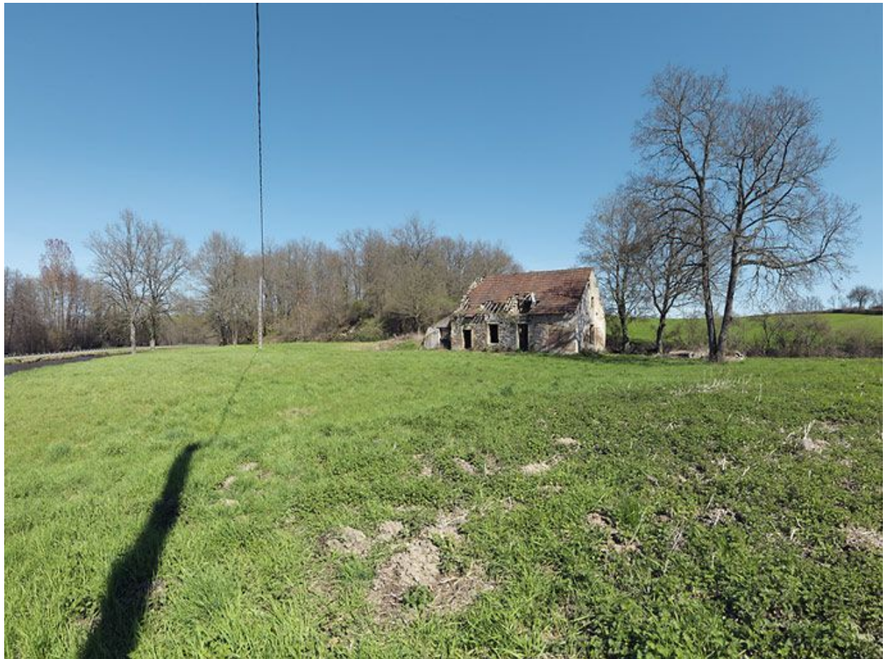
La maison éclusière.
