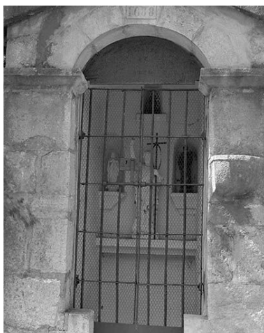
Porte d'accès à l'autel, grille. Phot. Jérôme Mongreville IVR43_20003900433X
