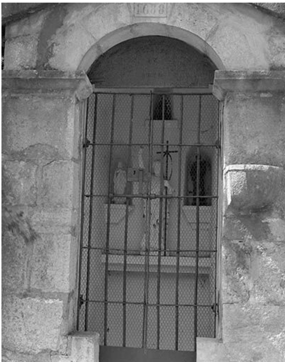
Porte d'accès à l'autel, grille.
