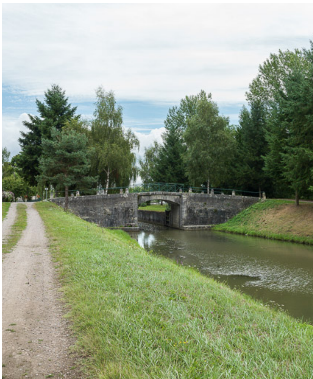
Vue d'ensemble du pont.
